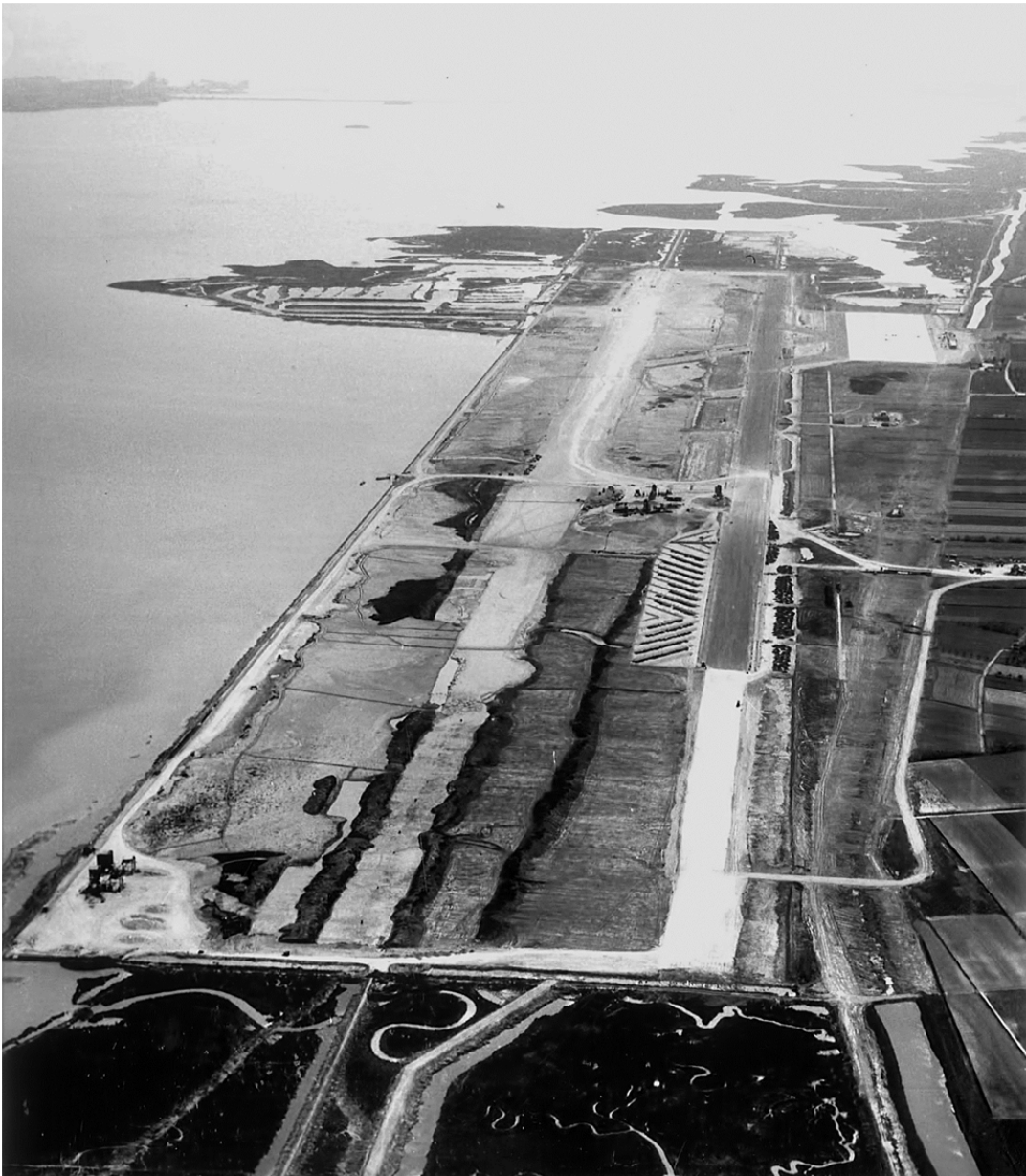
Figura C4-7 Foto scattata durante le fasi di costruzione della pista nel maggio 1960 (Fonte: Resini, 2008).
