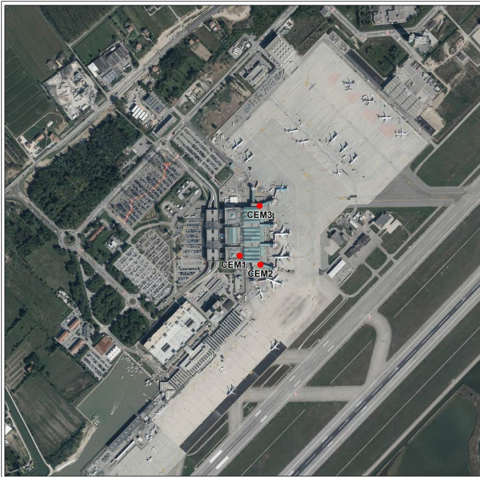
Figura C4-8 Postazioni di misura dei CEM nel terminal passeggeri (Fonte: SAVE S.p.A., http://ambiente.veniceairport.it/Home.aspx ).
