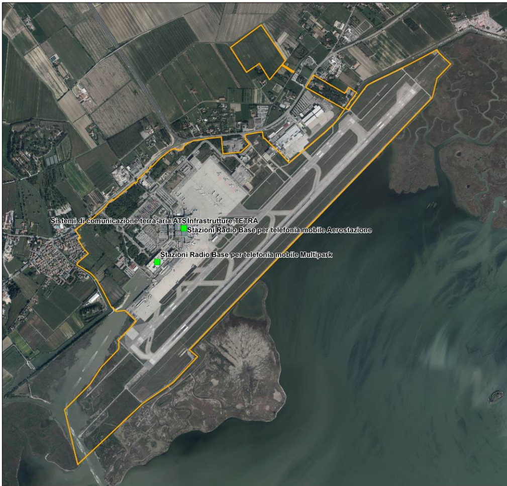
Figura C4-2 Ubicazione degli impianti di comunicazione terra aria e delle stazioni radio base per la telefonia mobile interni al sedime.
