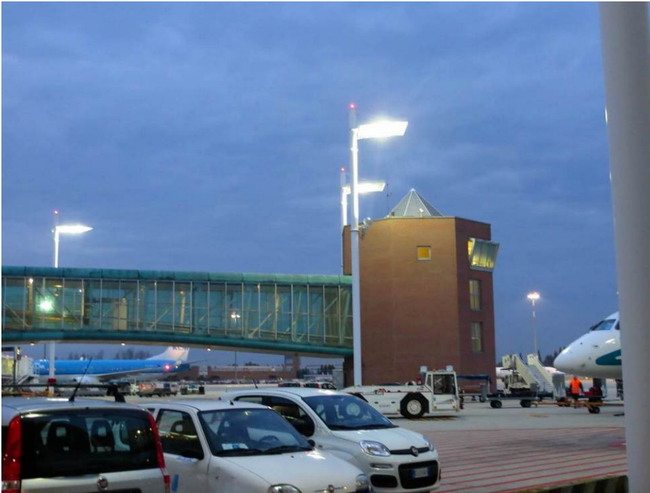
Figura C4-5 Torre faro a specchio in prossimità dei finger.
