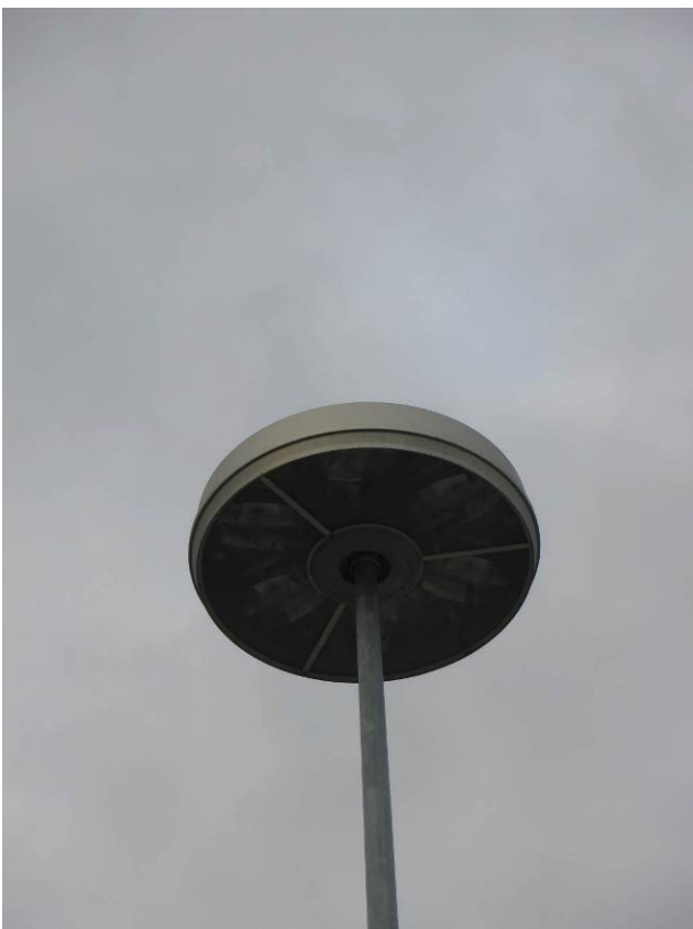
Figura C4-8 Torre faro a corona circolare - particolare.
