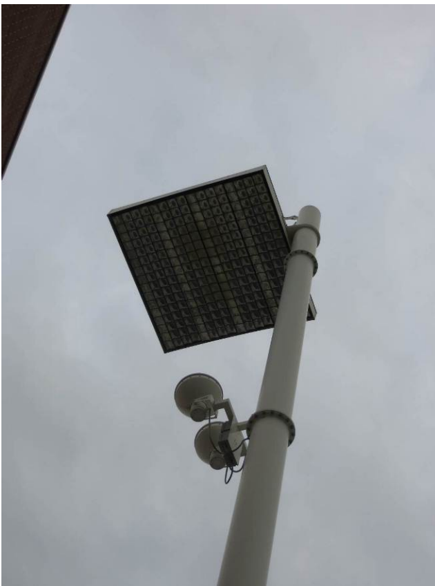
Figura C4-6 Torre faro a specchio (particolare).
