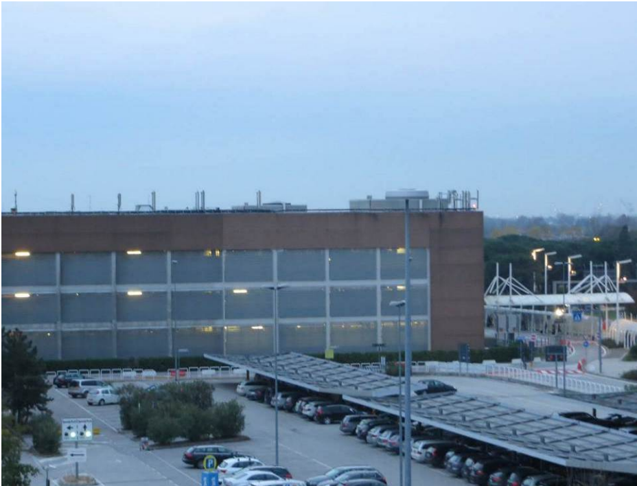
Figura C4-7 Torre faro a corona circolare di illuminazione del parcheggio dipendenti.
