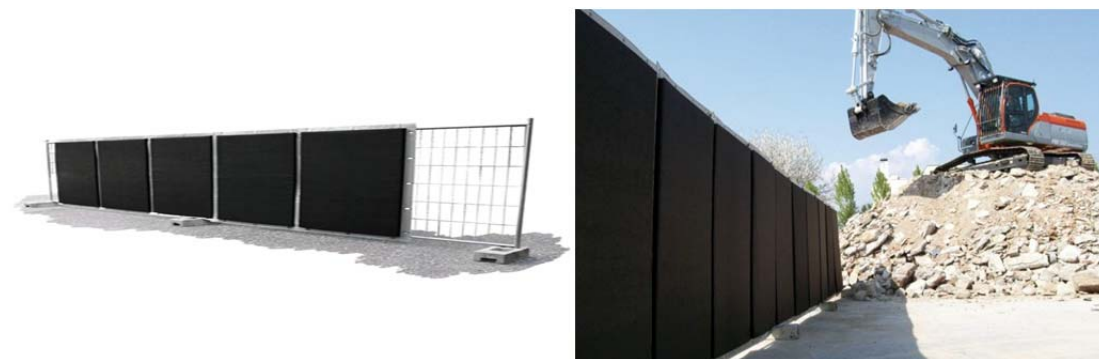
Figura C6-1 Esempio di barriere mobili di tipo fonoassorbente.
