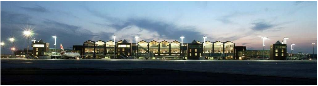
Vista del terminal dall'air side
