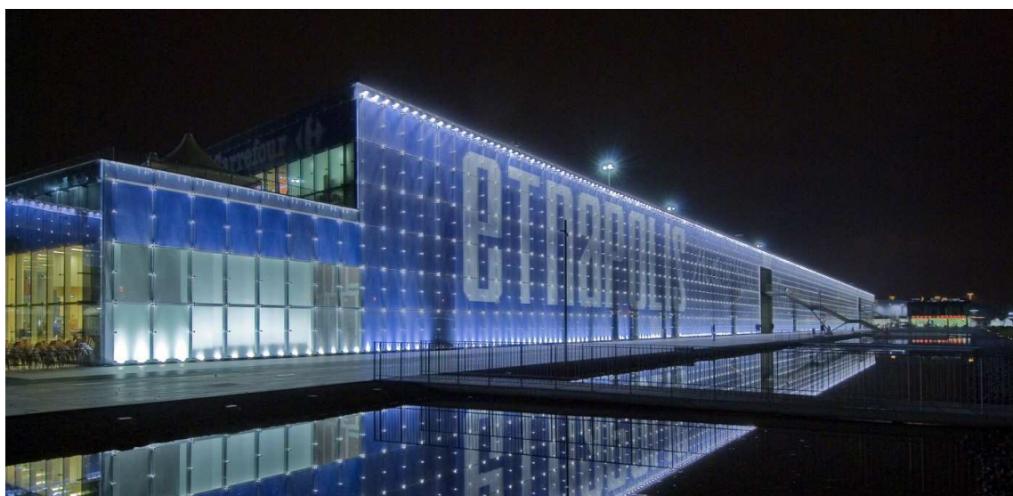
Figura 5.5: vista della facciata in doppi vetro e LED del Centro Commerciale "Etnapolis" di Catania
