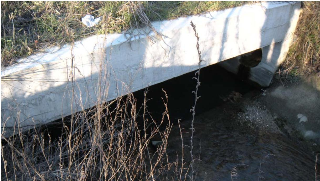
*Figura 1. Vista in piena e in magra dell'imbocco del manufatto di attraversamento della SR 14. Nell'immagine sotto si riconosce chiaramente il salto di fondo e il volume morto di acqua presente nella configurazione attuale. Per tale motivo, in piena risulta estremamente facile l'innalzamento dei livelli fin quasi alla sommità della luce.*
