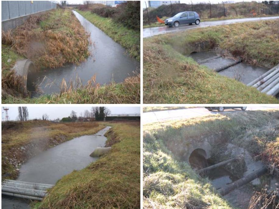
Figura 6. Tratti insufficienti di collettore Pagliaghetta in via Bonmartini che verranno bypassati.
