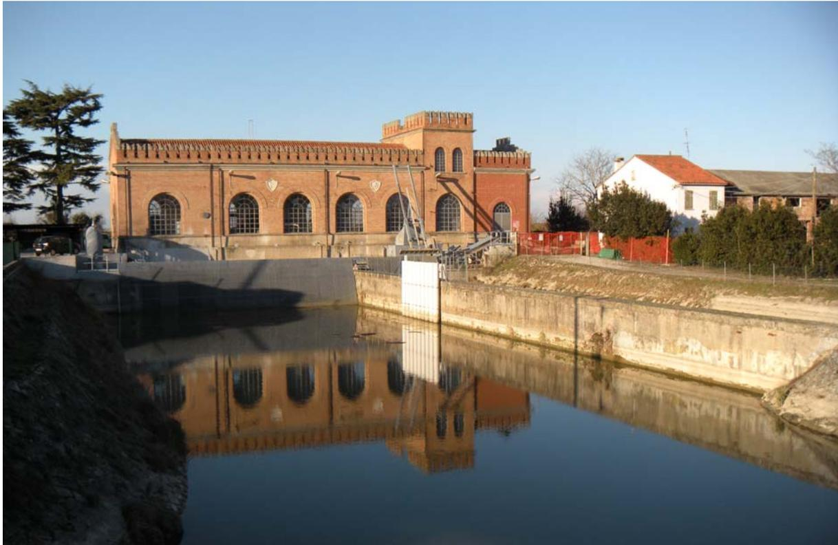
*Figura 4. Vista da monte dell'idrovora Cattal. A sinistra il mandracchio del comparto delle acque basse, mentre il collettore delle acque medie raggiunge l'idrovora dietro al muro in primo piano.*
