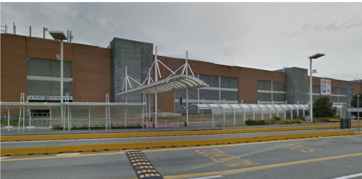
Viste del parcheggio multipiano esistente
