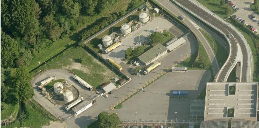
Il deposito carburanti Si vede sulla destra i terminal e le rampe della viabilità
