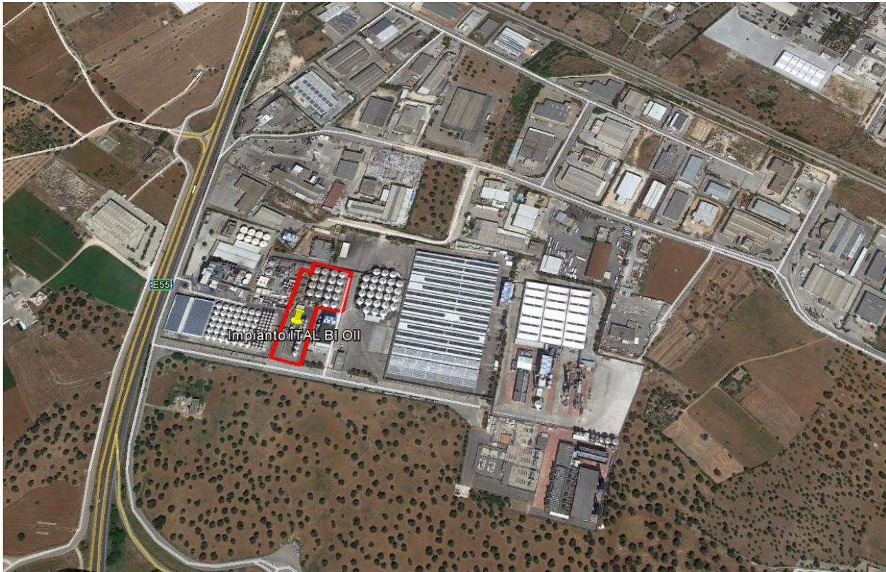
Figura 3.B - Particolare impianto Ital Bi Oil (fonte Google Earth)
