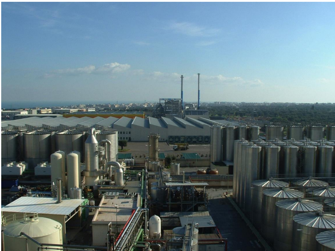
Area industriale di Monopoli
