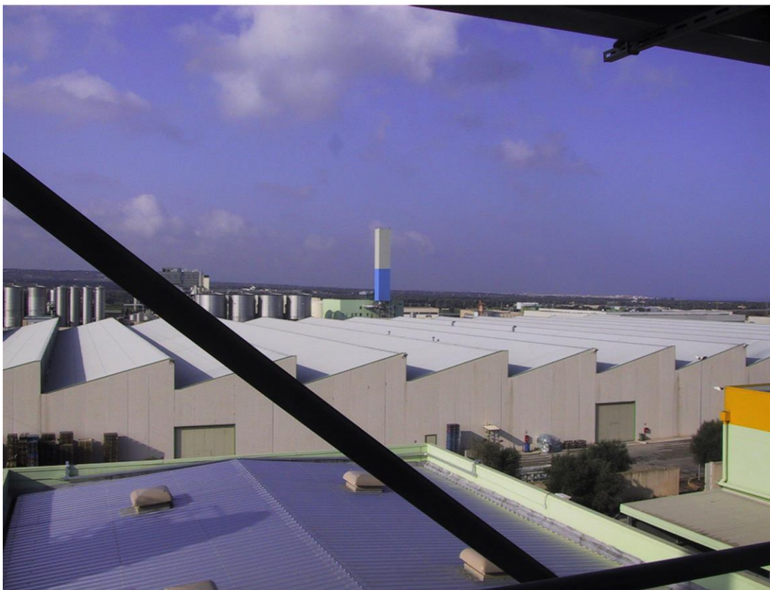
Area industriale di Monopoli
