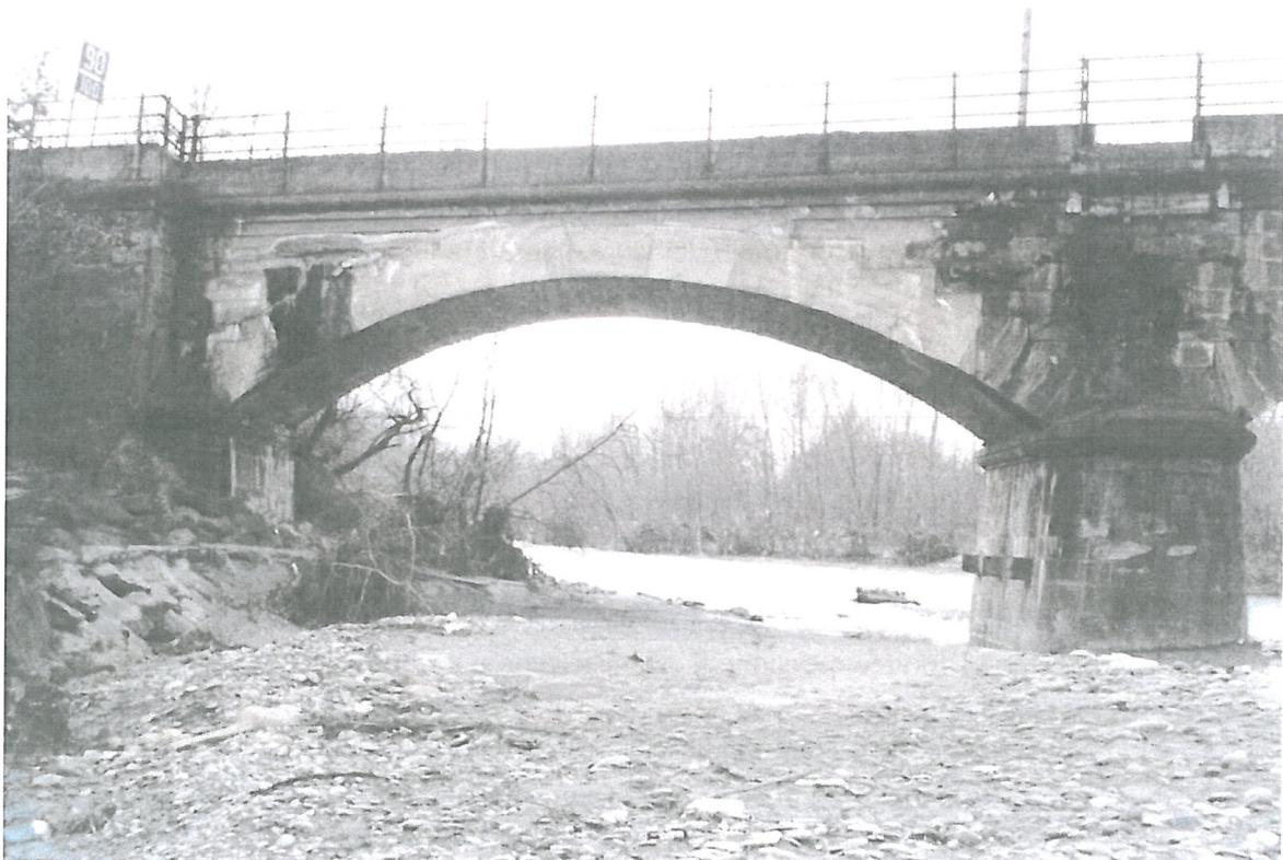
*Figura 8 – Ponte Dora in muratura visto da valle: arco laterale lato Meana ricostruito in cemento armato*
