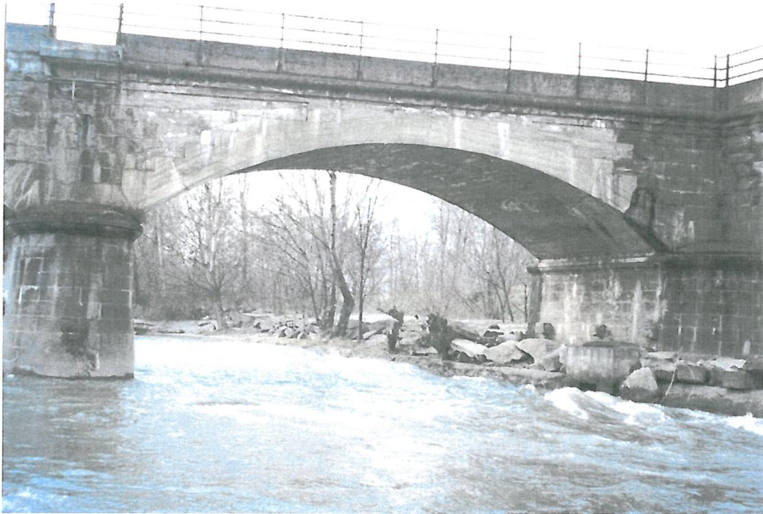
*Figura 7 – Ponte Dora in muratura visto da valle: arco laterale lato Bussoleno ricostruito in cemento armato.*
