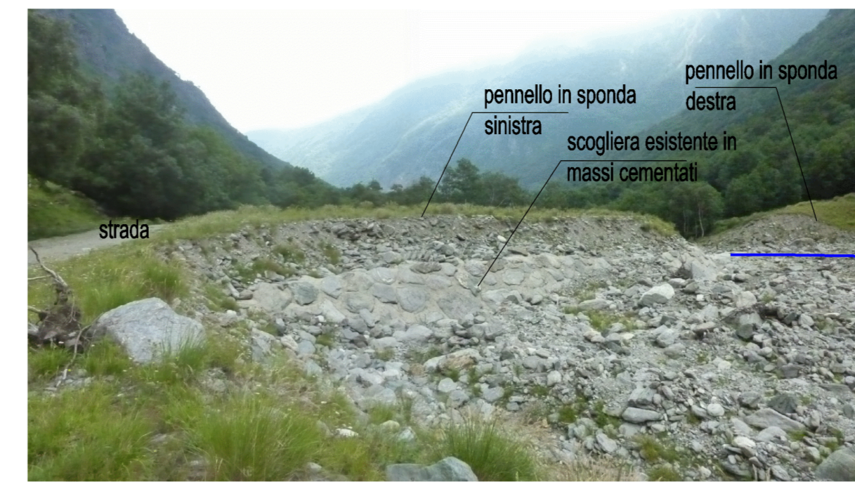
F-05 - vista verso valle della sponda sinistra a monte del pennello
