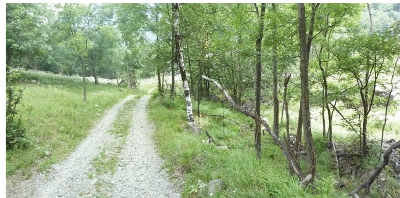
F-02 - vista verso valle della strada in sponda sinistra a valle del pennello
