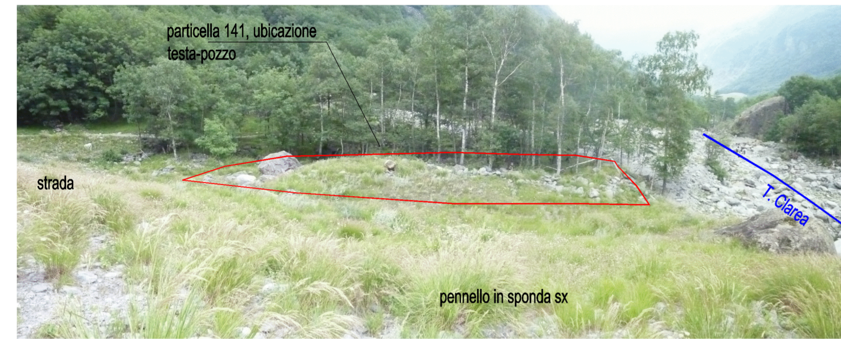
F-04 - vista a valle del pennello in sponda sinistra
