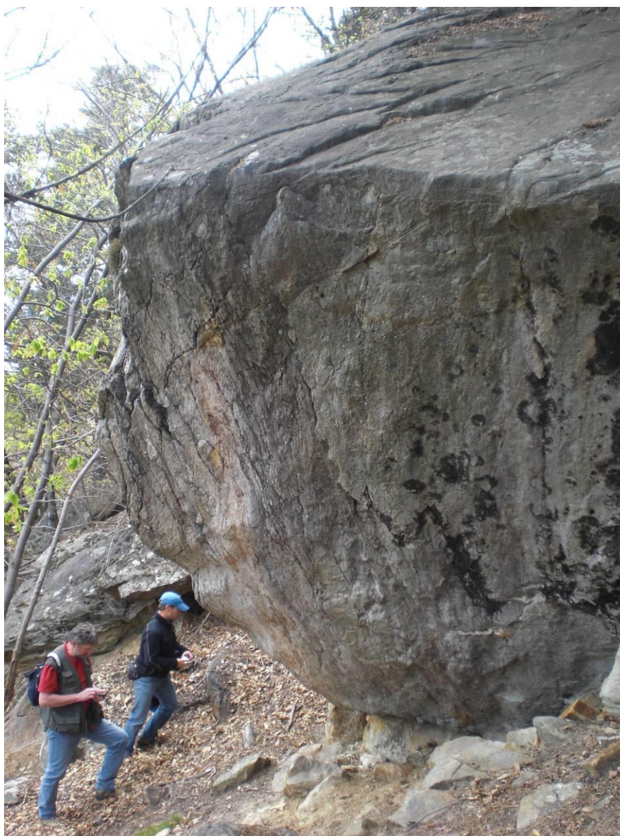
Fig. 10 –Esempio di masso ciclopico da monitorare attraverso l'installazione di clinometri e tiltimetri.
