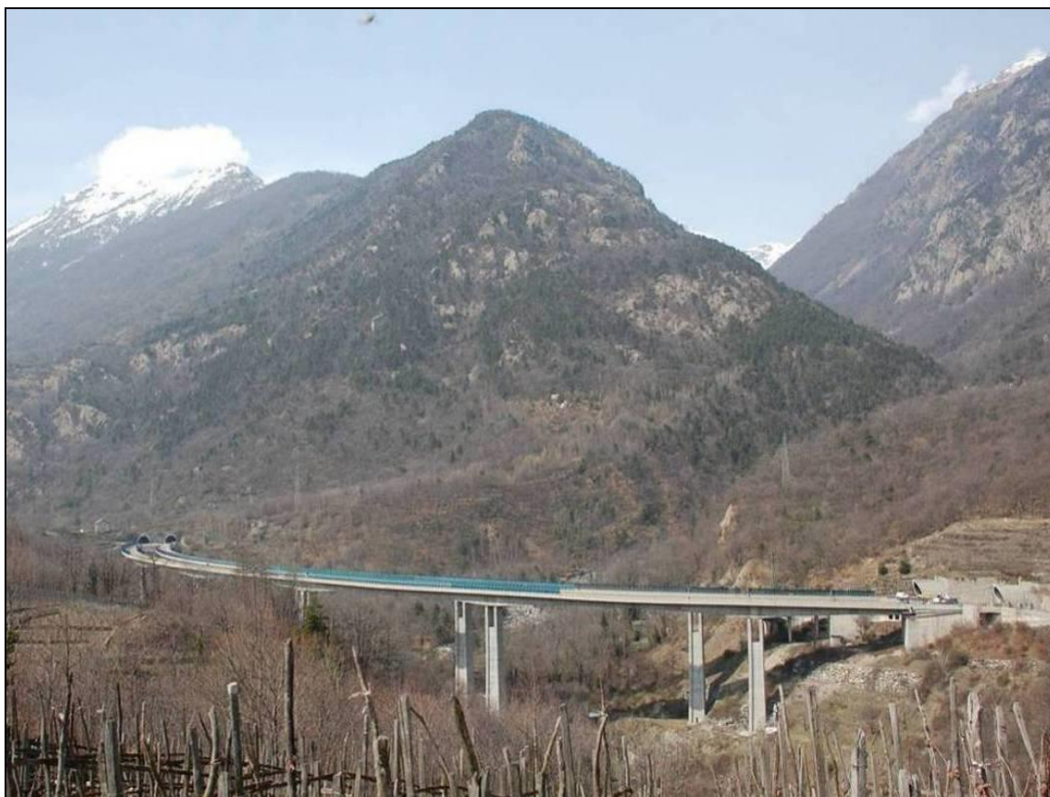
Fig. 1 – Vista panoramica dell'area di studio.
