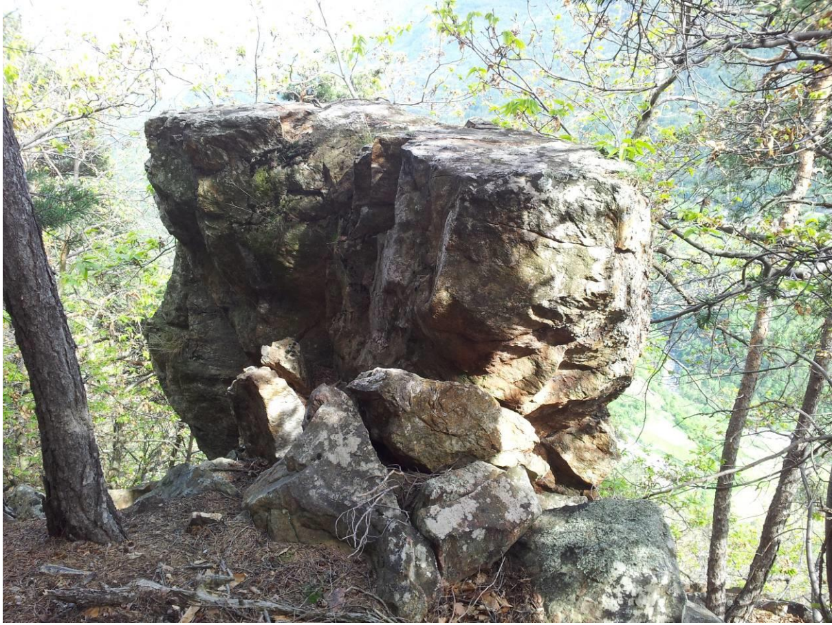
Fig. 13 – Esempio di masso “appoggiato” da monitorare per mezzo di clinometri.
