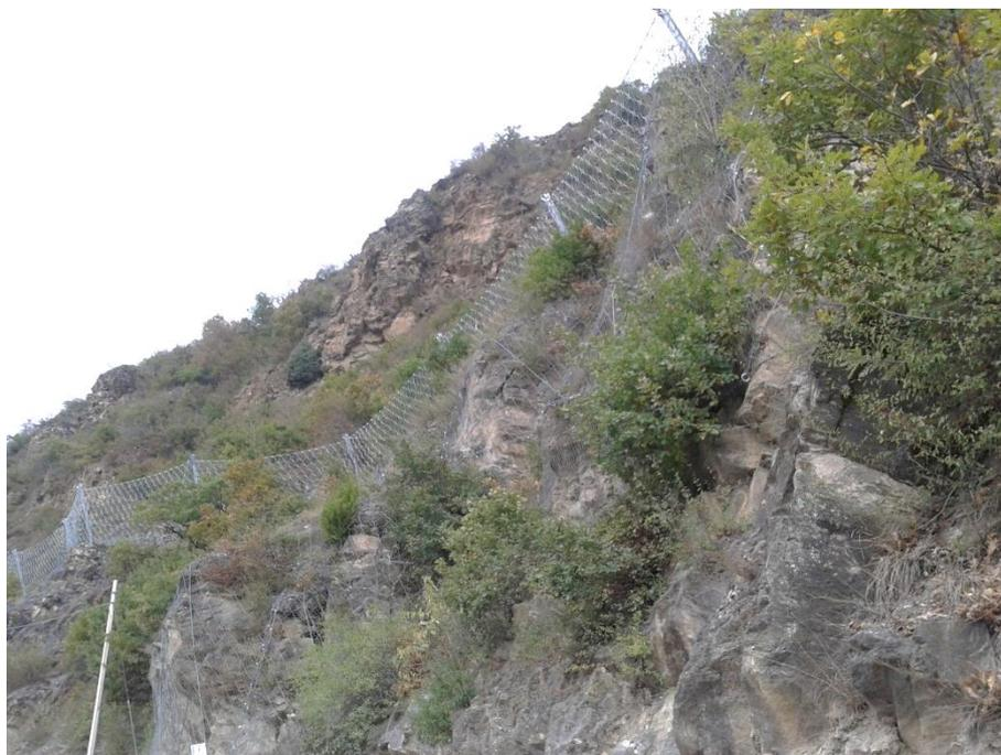
**Figura 22** – Barriere paramassi installate nel 2012 lungo la strada per Seghino (quota 660 m circa).
