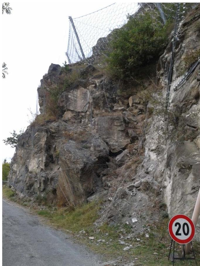
**Figura 25** – Massi instabili fratturati sopra la stradastrada per Seghino (quota 660 m circa).
