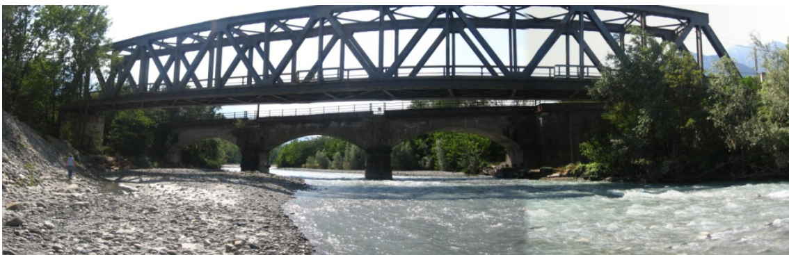
Figura 13 – Ponti ferroviari esistenti sulla Dora Riparia: a campata unica (primo piano) e a tre campate (in secondo piano) (foto da valle verso monte).
