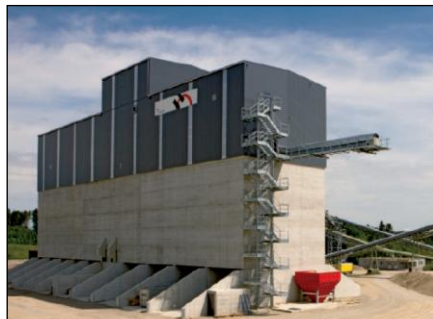
Figura 14 – Impianto di valorizzazione dei materiali di scavo – Particolare della tipologia di schermatura contro rumore e polveri
