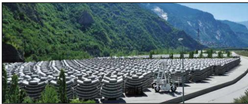
Figura 13 – Stoccaggio dei conci prefabbricati per il cantiere della Galleria di Sicurezza del Frejus (presso St. Etienne de Cuines) – Movimentazione con carro-ponte su gomma
