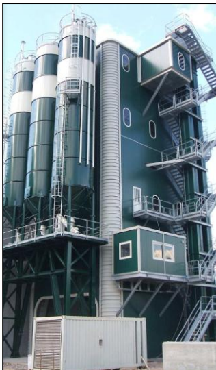
Figura 11 – Impianto di betonaggio con silos verticali – Particolare della tipologia di schermatura contro rumore e polveri
