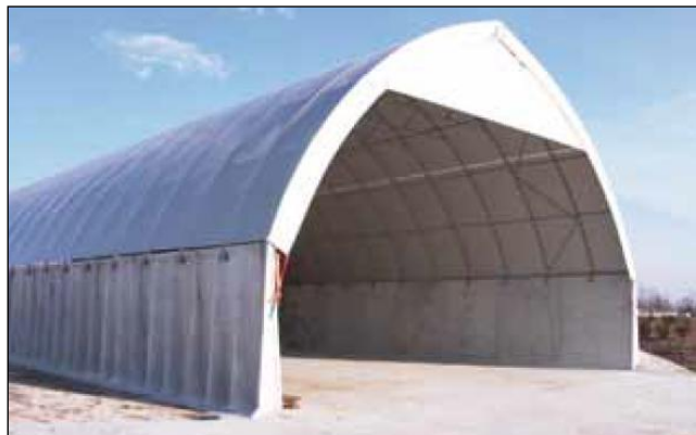
Figura 30 – Silos orizzontatale con copertura tipo “tenso-struttura”
