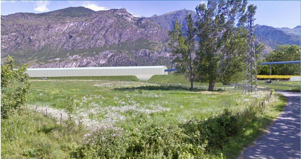
*Figura 16 - Fotoinserimento del nastro trasportatore, della duna vegetale e di un capannone di cantiere, nastro trasportatore azzurro (PD2\_C3C\_0228: AlbumFotoinserimenti\_A - 2013)*
