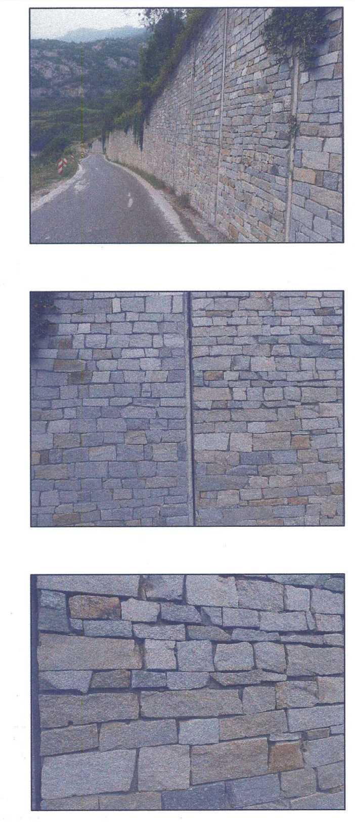
Particolare del muro di contenimento (muretti esistenti lungo la strada dell'Avanà)
