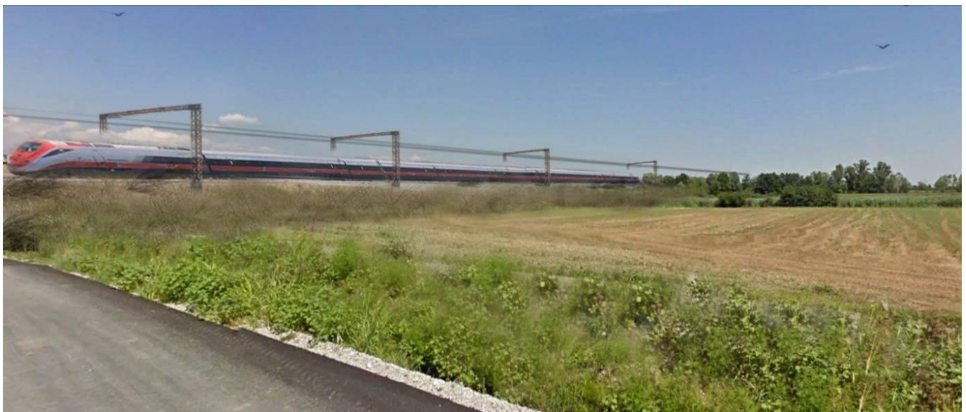
Figura 4-1- Tratto di linea ferroviaria in rilevato nel territorio comunale di Flero. Dall'alto in basso: inquadramento, vista dello stato di fatto (in costruzione il raccordo Ospitaletto-Montichiari), foto inserimento del progetto ferroviario (per le opere di mitigazione si rimanda al par. 4.3).
