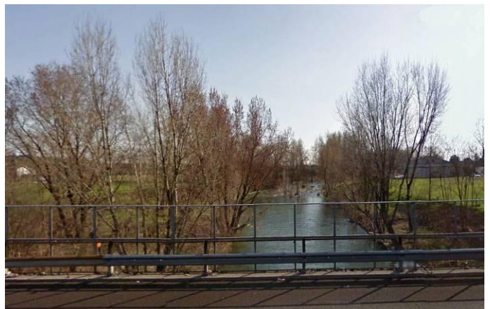
Figura 2-21 – Attraversamento del fiume Chiese dall'Autostrada A4
