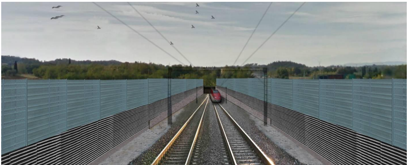
Figura 4-5- Sbocco della galleria Lonato est. Dall'alto in basso: inquadramento, vista dello stato di fatto, foto inserimento del progetto ferroviario (per le opere di mitigazione si rimanda al par. 4.3).
