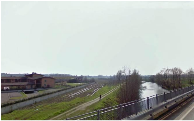
Figura 2-10 – vista del Fiume Mella nel punto in cui verrà attraversato dalla linea ferroviaria
