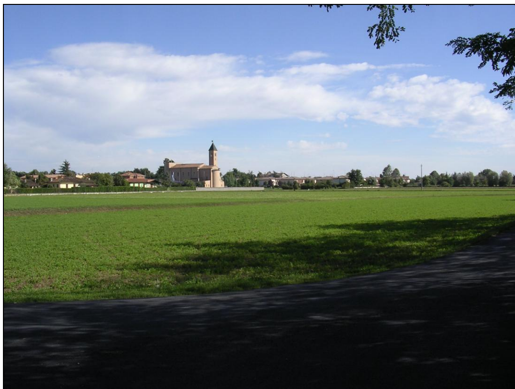
Figura 4.6-4: Nella ripresa fotografica è visibile la Chiesa dell'abitato di Capodimonte in prossimità della fine dell'intervento in progetto.
