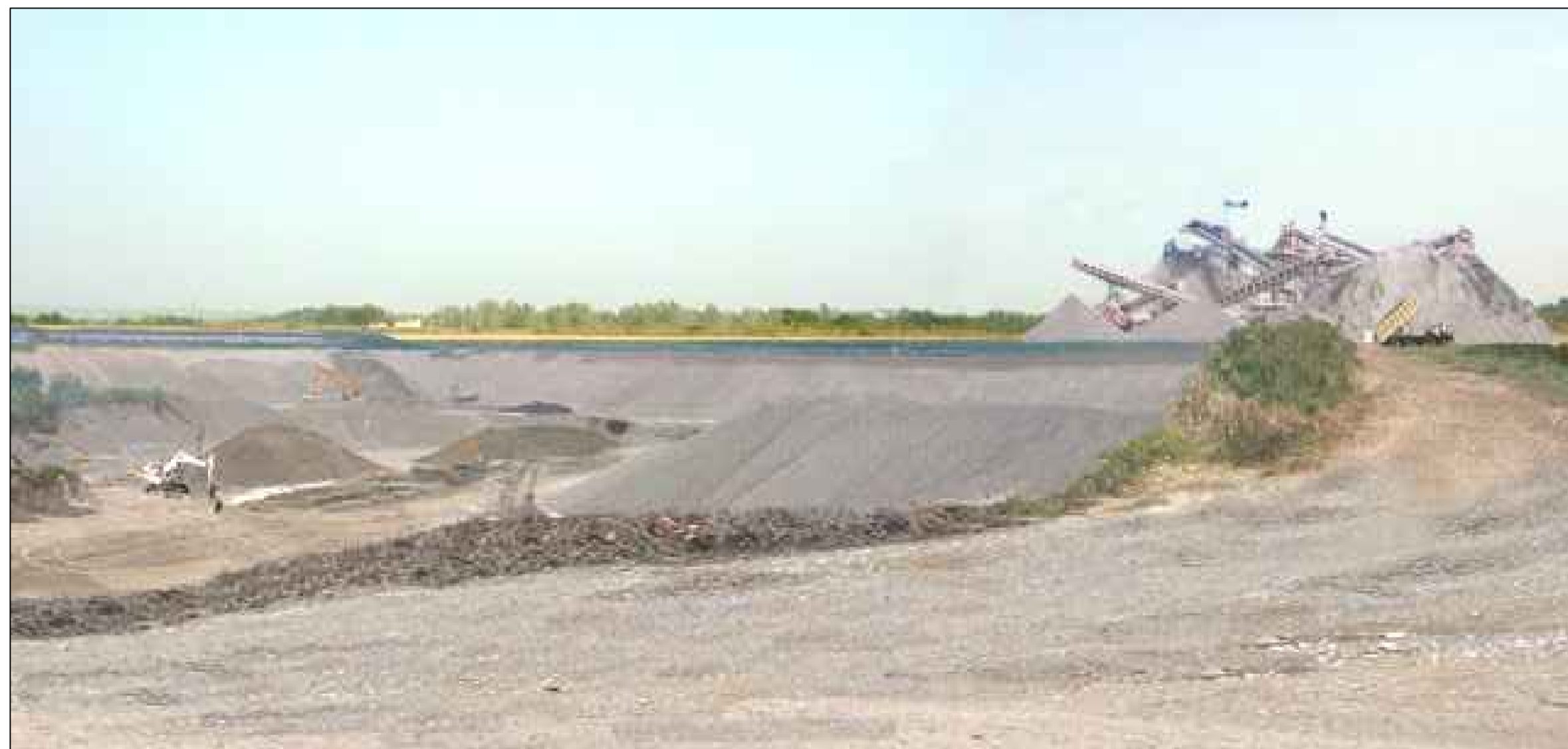
CAVA VR1 - Vista da Ovest In corso d'opera
