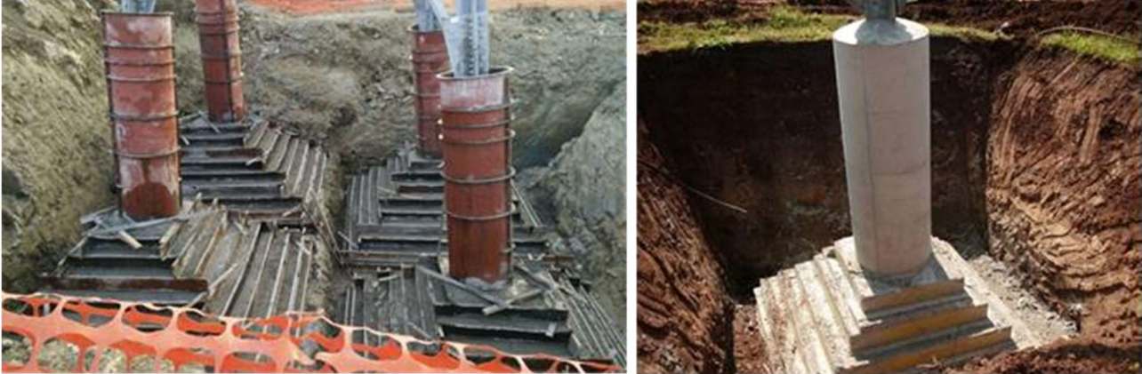
Figura 5-2 Realizzazione di fondazioni superficiali tipo CR per un sostegno a traliccio. Particolare di una fondazione durante la fase di cassetteria (a sinistra) e al termine della stessa (a destra), dove si possono distinguere facilmente la parte inferiore a parallelepipedo tronco piramidale ed il colonnino di raccordo con la “base” del sostegno.
