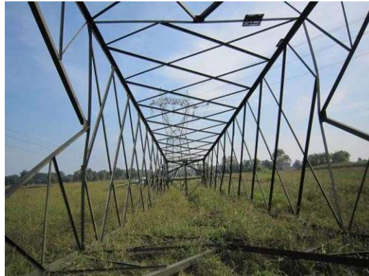
Figura 5-5: Fasi demolizione di un sostegno a traliccio
