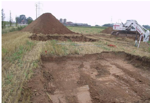
Figura 2.5-1: Esempio di fase di tracciamento e scotico terreno di un micro-cantiere
