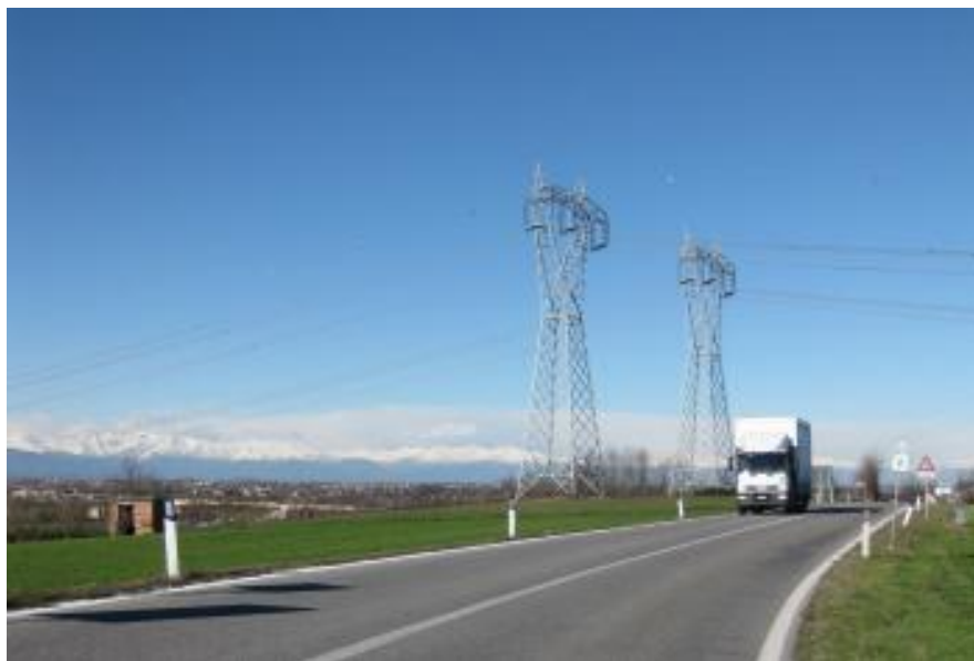
Foto 7: Viabilità principale nei pressi dell'esistente Stazione Elettrica di Magliano Alpi
