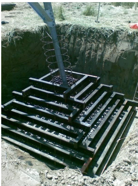
Figura 2.5-3: Esempio di realizzazione del piede di fondazione
