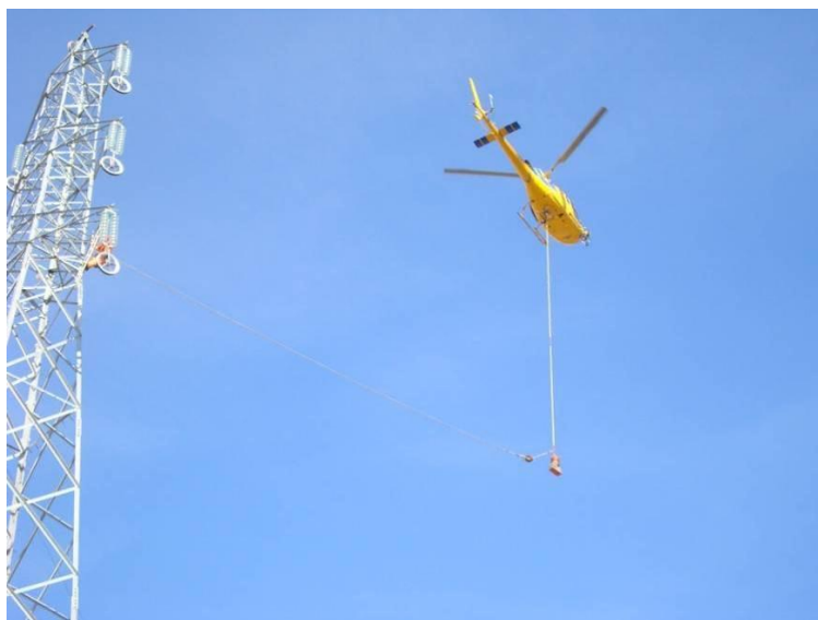
Figura 2.5-7 Esempio di l’utilizzo dell’elicottero per la stesura della corda pilota
