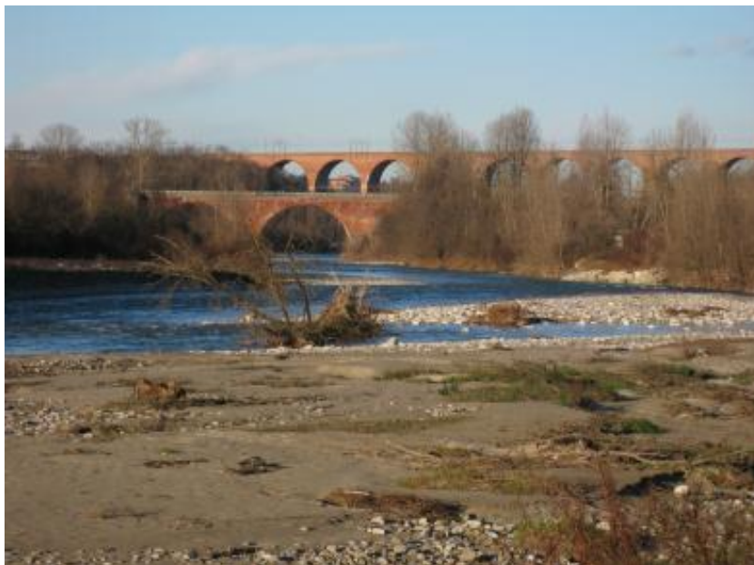
Foto 1: Alveo del Torrente Stura di Demonte in prossimità dell'attraversamento
