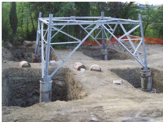
Figura 2.5-2: Esempio di fondazione di un sostegno
