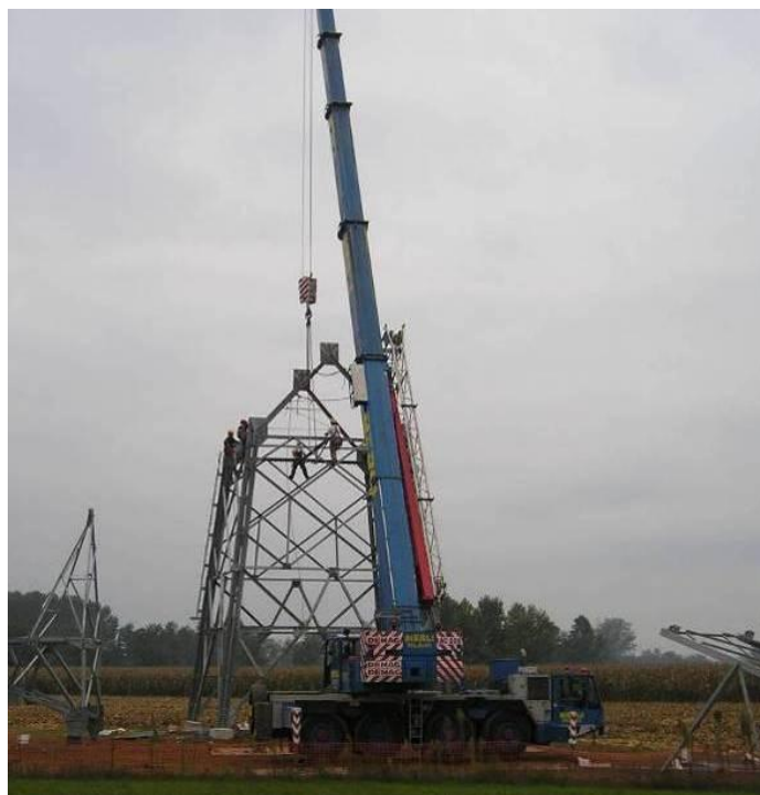
Figura 2.5-5: esempio di montaggio sostegno mediante l'ausilio di autogrù
