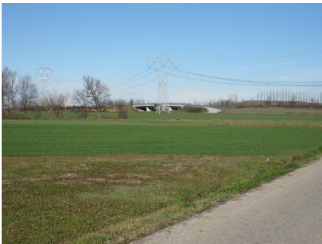
Foto 30: Linee elettriche ad alta tensione e autostrada (A33) nei pressi della SE Terna di Magliano Alpi
