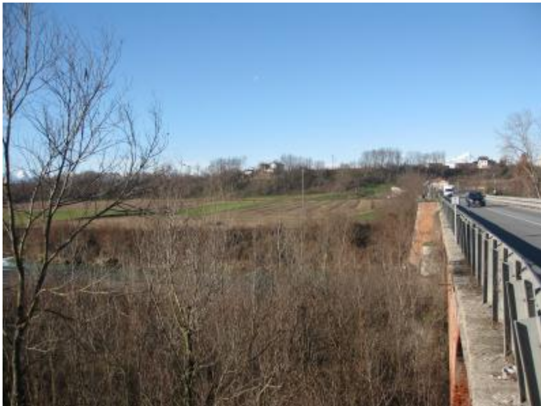
Foto 14: Vista dell'area interessata dall'attraversamento della nuova linea aereo sul Torrente Stura di Demonte dal ponte stradale (Punto di Vista n.3)
