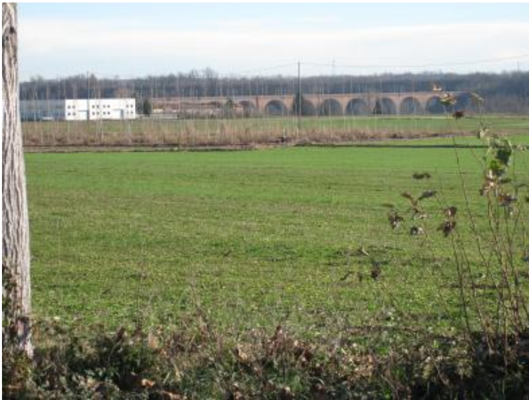
Foto 13: Ponte ferroviario sul Torrente Stura di Demonte
