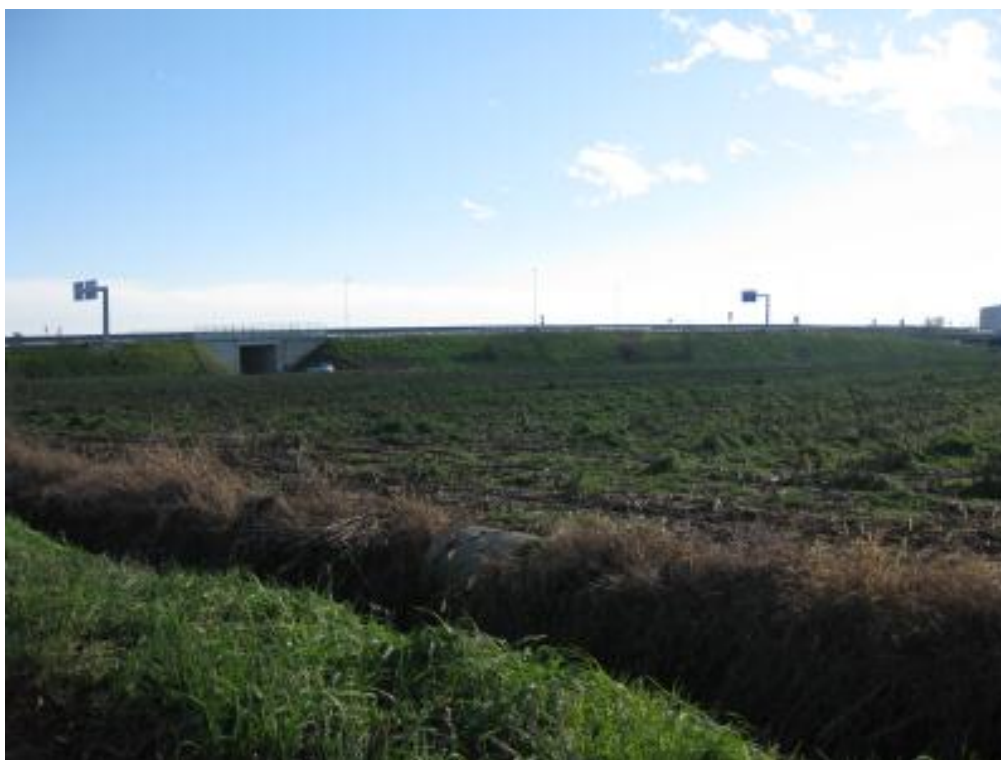
Foto 5: Tangenziale di Cuneo (SS28), a cui il secondo tratto del cavidotto interrato correrà in affiancamento
