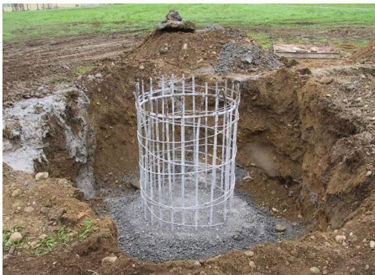
Figura 3.4.5.1-3: fondazione trivellata prima del collegamento con il moncone del traliccio
