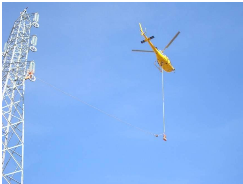
Figura 3.4-13 Esempio di l'utilizzo dell'elicottero per la stesura della corda pilota
