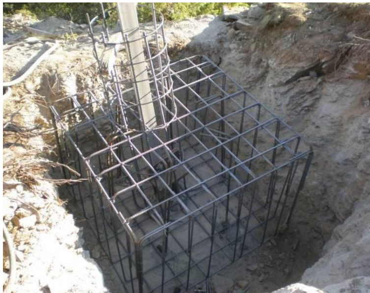
Figura 3.4.5.1-3: Dado di collegamento tra micropali e moncone-traliccio
