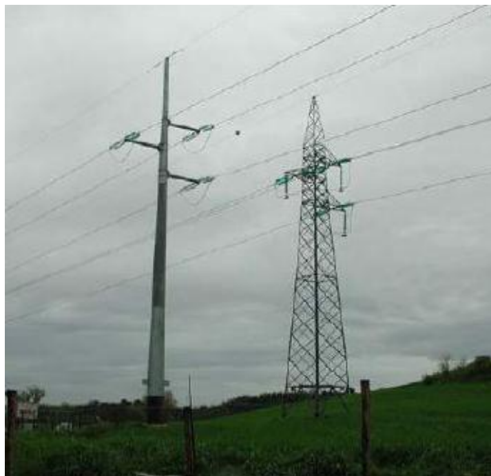
Figura 4.3-32: Palo monostelo e traliccio
