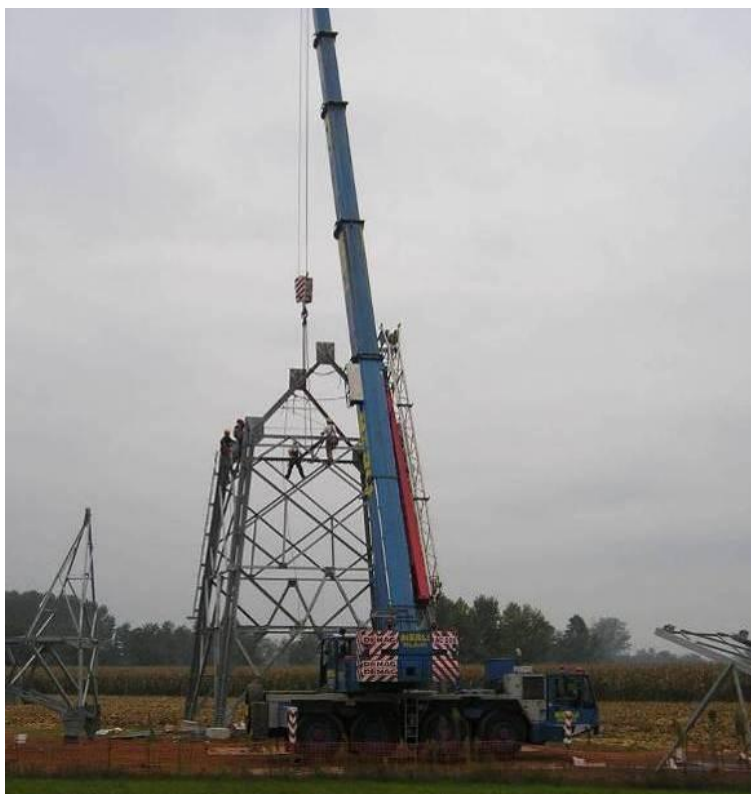
Figura 3.4.5.1-3: Esempio di montaggio sostegno mediante l'ausilio di autogrù
