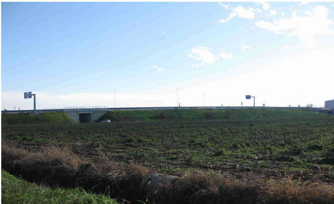
Figura 4.3-20: Tangenziale SS231 accanto al tracciato della quale sarà posizionato il cavidotto
