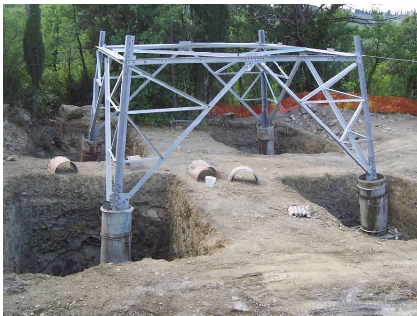
Figura 3.4-9: Esempio di fondazione di un sostegno
