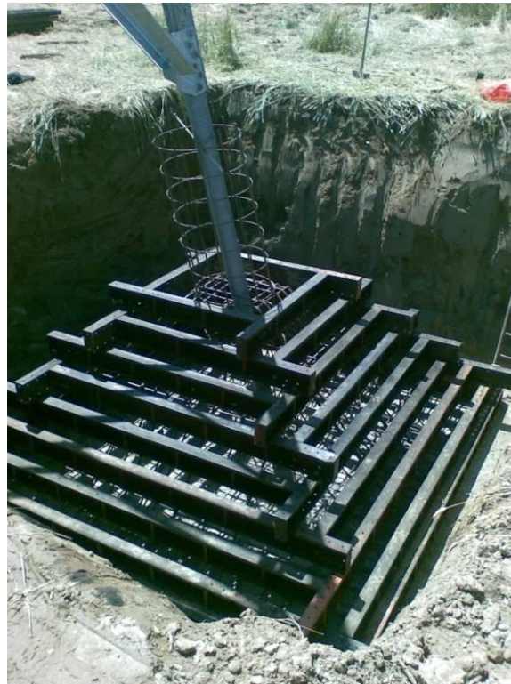
Figura 3.4-10: Esempio di realizzazione del piede di fondazione
