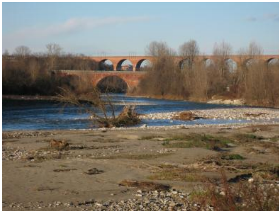
Figura 4.3-28: Ponti in prossimità dell'attraversamento sullo Stura della linea elettrica in progetto
