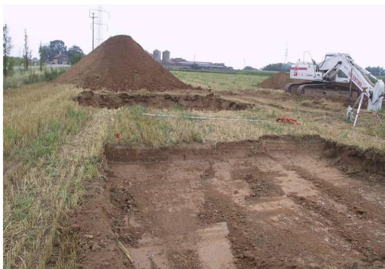
Figura 3.4-8: Esempio di fase di tracciamento e scotico terreno di un micro-cantiere
