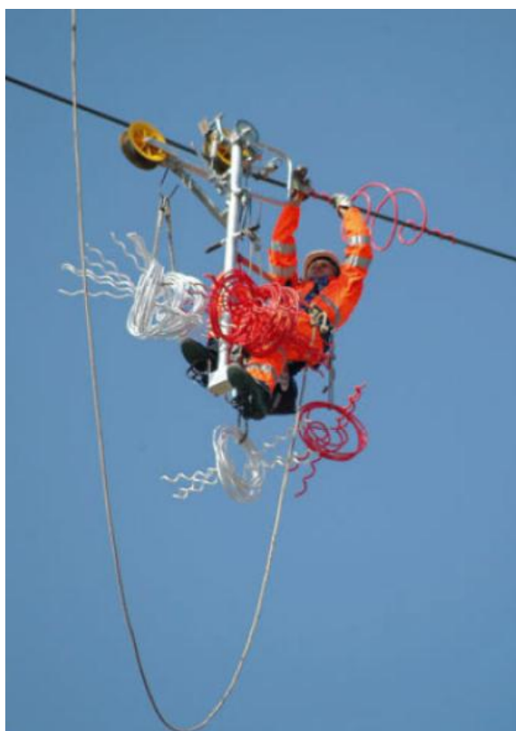
Figura 4.3-31: Montaggio dissuasori di segnalazione per avifauna
