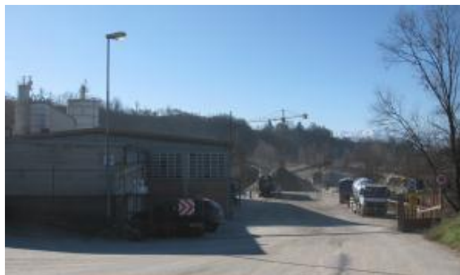
Foto 3: Impianto di estrazione di inerti lungo la sponda del T. Stura di Demonte
