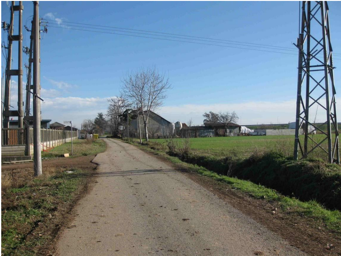
Figura 4.3-19: Strada vicinale S. Chiara in corrispondenza della cabina primaria (sulla sinistra)
