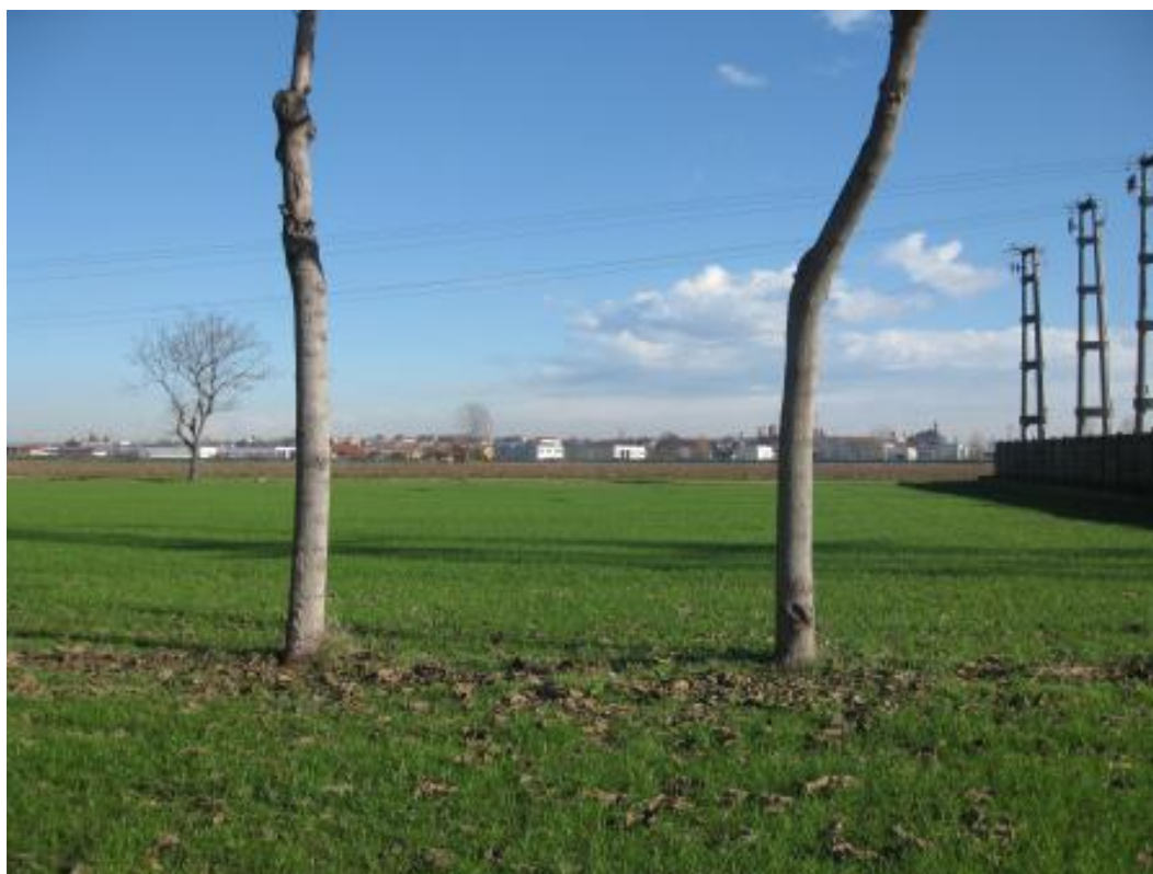
Foto 3: Area di partenza del cavo interrato, confine Nord della CP Enel di Fossano e sullo sfondo abitato di Fossano
