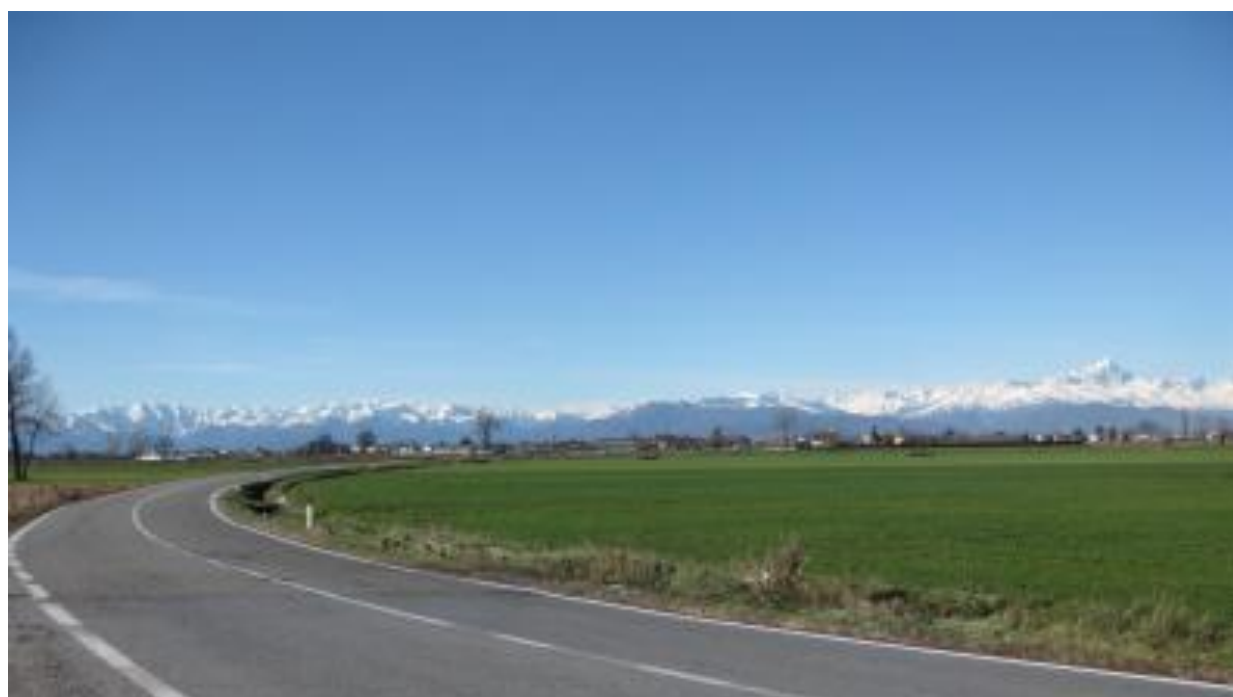
Foto 20: Strada Statale n.28 e seminativi nei pressi dell'abitato di Trinità
