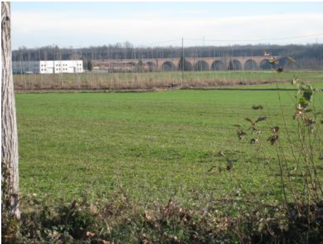
Foto 13: Ponte ferroviario sul Torrente Stura di Demonte
