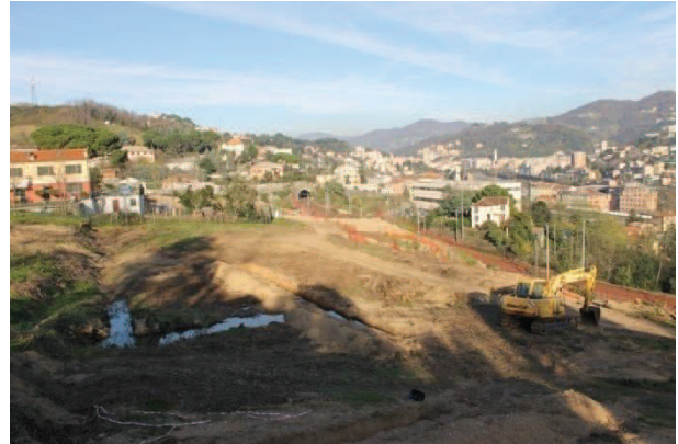
Overview dell'area di cantiere
