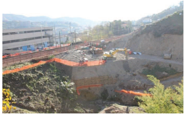
Attività di cantiere
