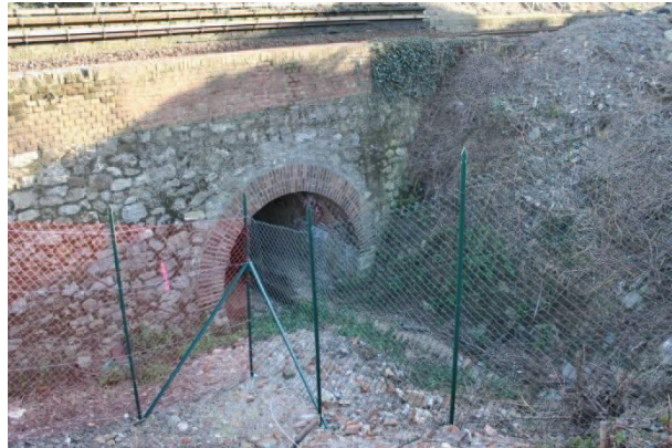
Corso d'acqua che attraversa il cantiere
