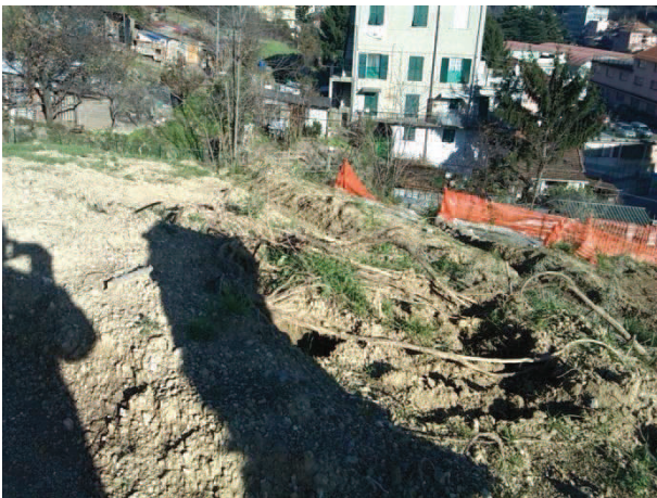
Effetti dell'attività di cantiere
