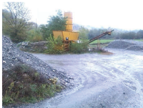
Area di cantiere pianeggiante
