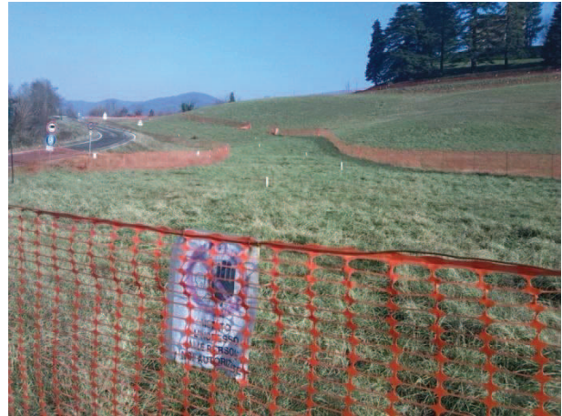
Delimitazione area di cantiere
