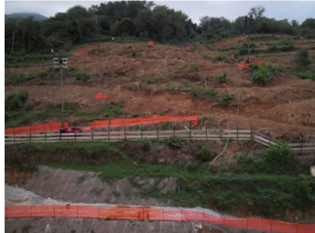
Overview del cantiere
