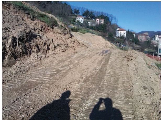
Effetti dell'attività di cantiere
