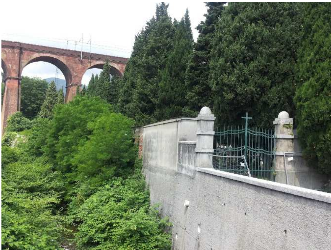
Foto 1. FAU-GE-060. Veduta dell'area di monitoraggio
