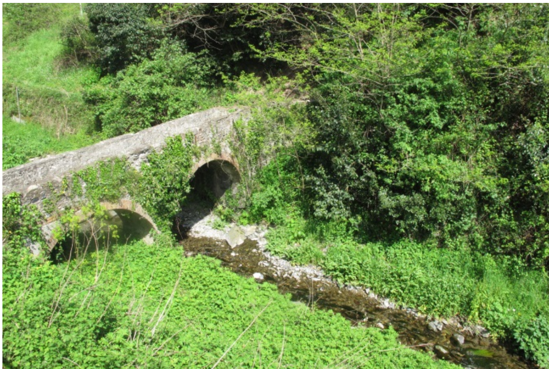
Foto 1. FAU-GE-061. Particolare dell'area di indagine.
