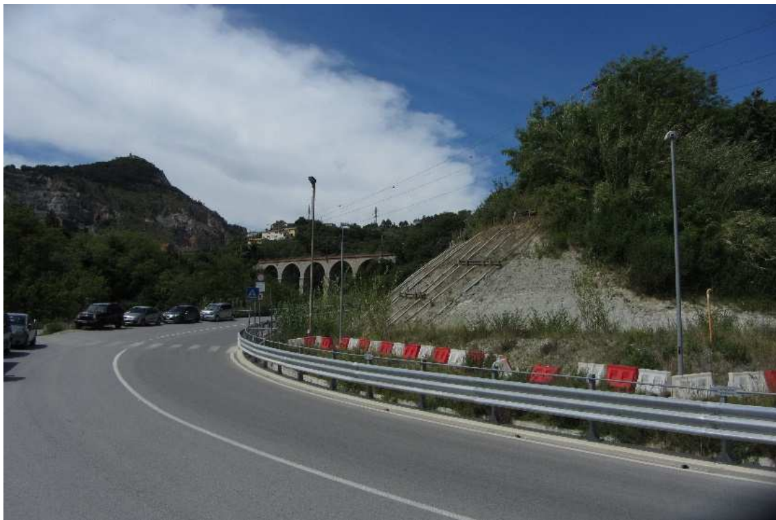
Fig. 1. FAU-GE-030. Particolare della stazione di monitoraggio
