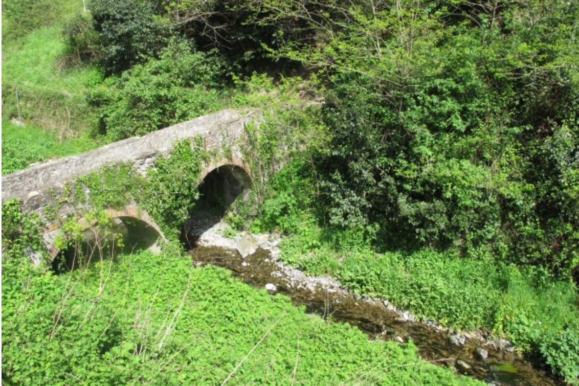
Foto 1. FAU-GE-061. Particolare dell'area di indagine
