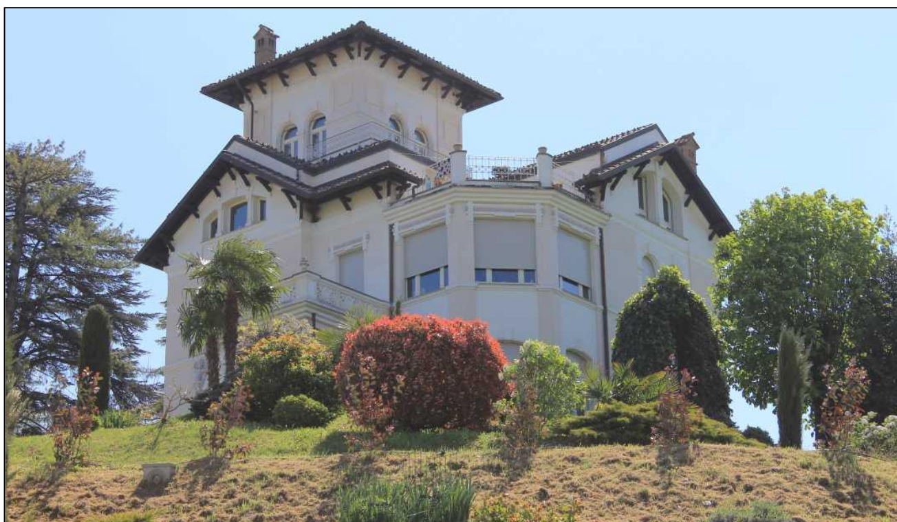
Figura 22 - Villa lungo la via Moriassi
