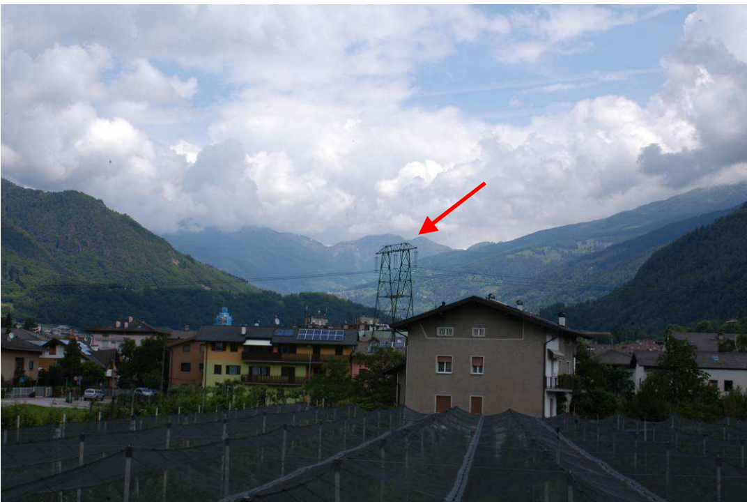
Fig. 41 - Vista dell'elemento di disturbo verticale ed orizzontale collocato in mezzo all'abitato di Pergine
