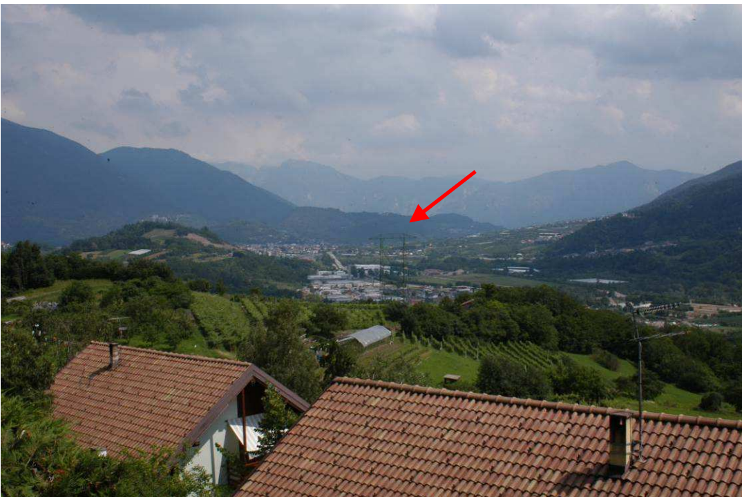
Fig. 43 - Ripresa fotografica della Linea che verrà demolita a Nord di Civezzano– evidente il sostegno in posizione sommitale (vista dalle case di Roverè)
