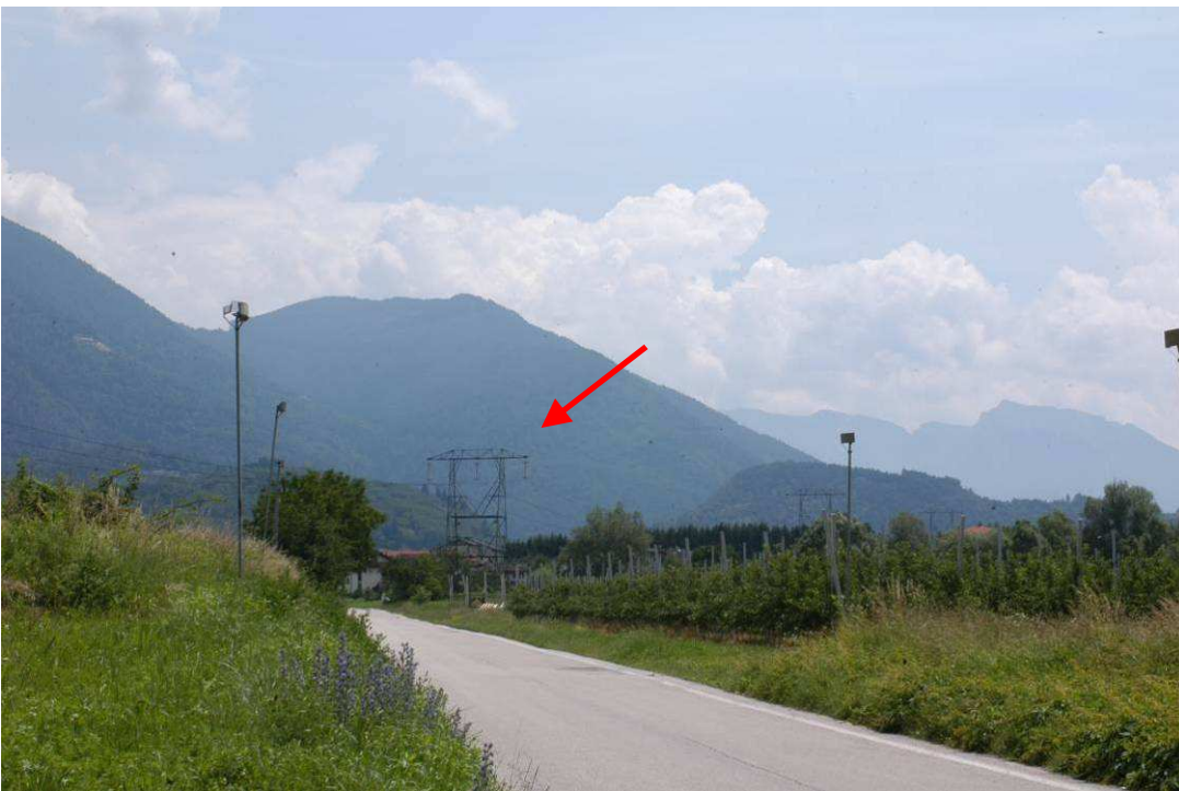
Fig. 49 - Ripresa di un esempio di collocamento di sostegno in zona agricola nella conca di Pergine.
