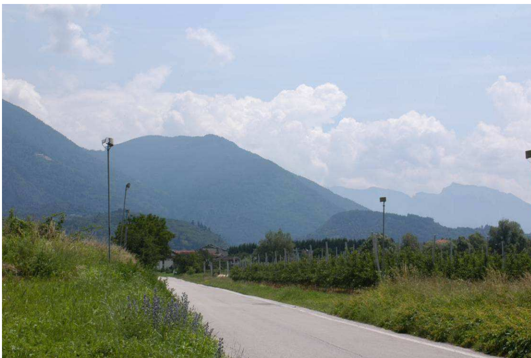
Fig. 50 - Evidente alterazione del quadro compositivo a seguito della demolizione del sostegno della vecchia Linea.
