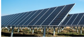
Impianto sub-verticale fisso con inclinazione 35°
