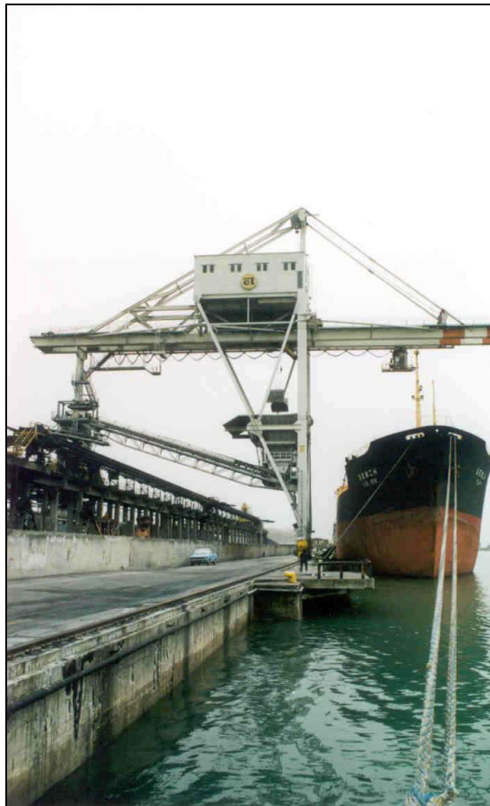
FIGURA 2-5 CARRO PONTE SULLA BANCHINA DEL TERMINAL RINFUSE
