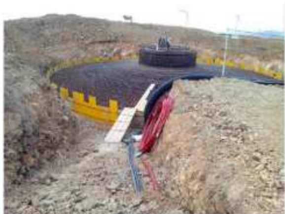
Posa ferri e cassetatura
