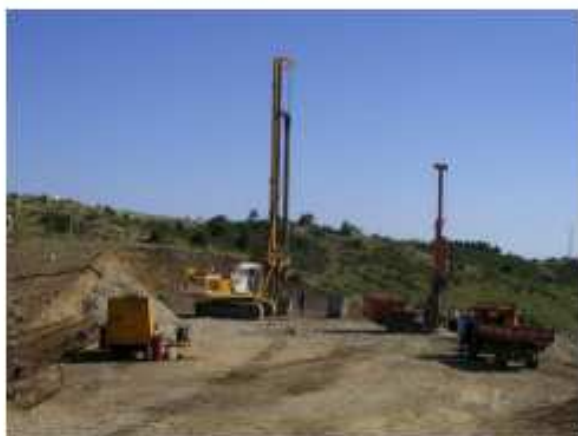
Realizzazione pali trivellati
