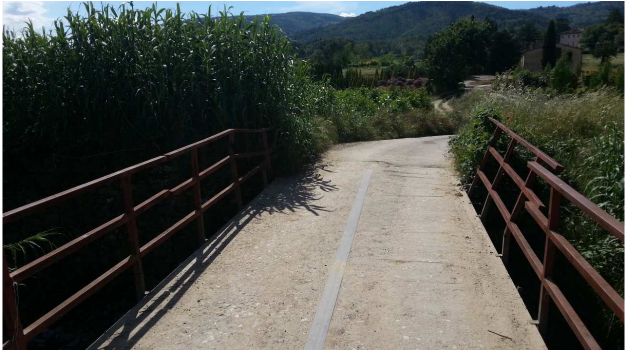
Figura 9- PONTE SUL TORBECCHIA ATTUALE
