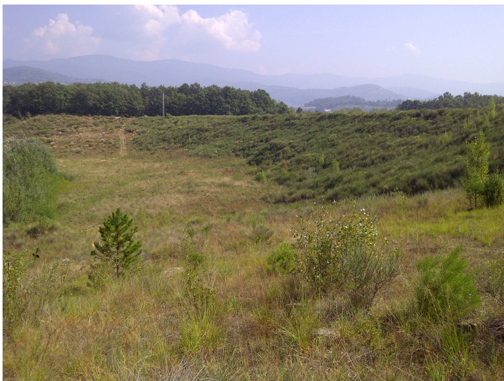
Foto 6: vista paramento di monte dall'interno dell'invaso
