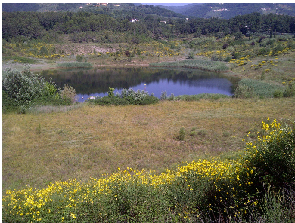
Foto 3: vista dell'invaso dal coronamento
