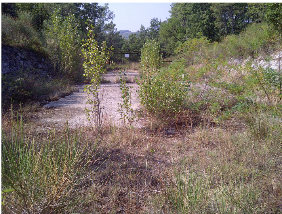
Foto 8: vista del canale scolmatore da monte verso valle
