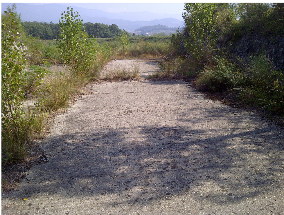
Foto 9: vista del canale scolmatore da valle verso monte
