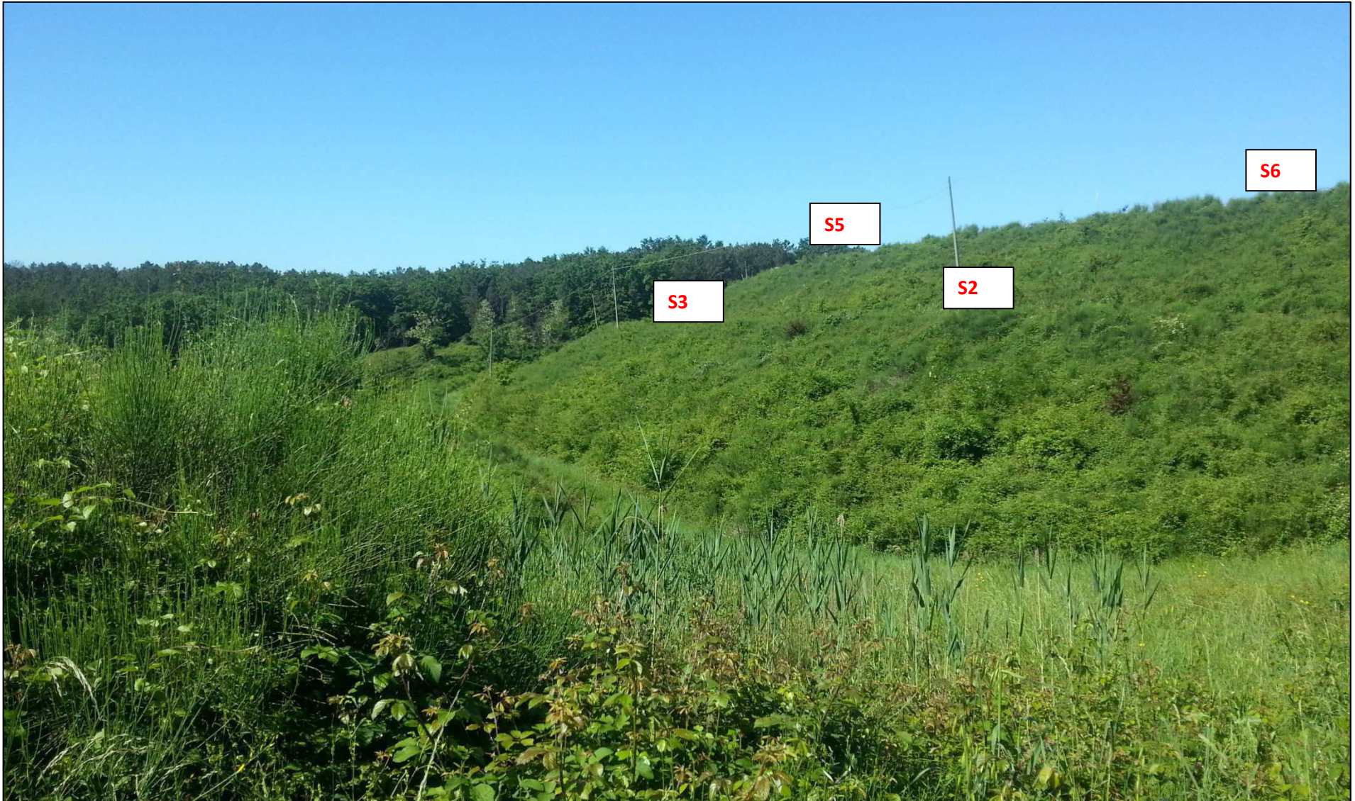
Panoramica lato valle Rilevato
