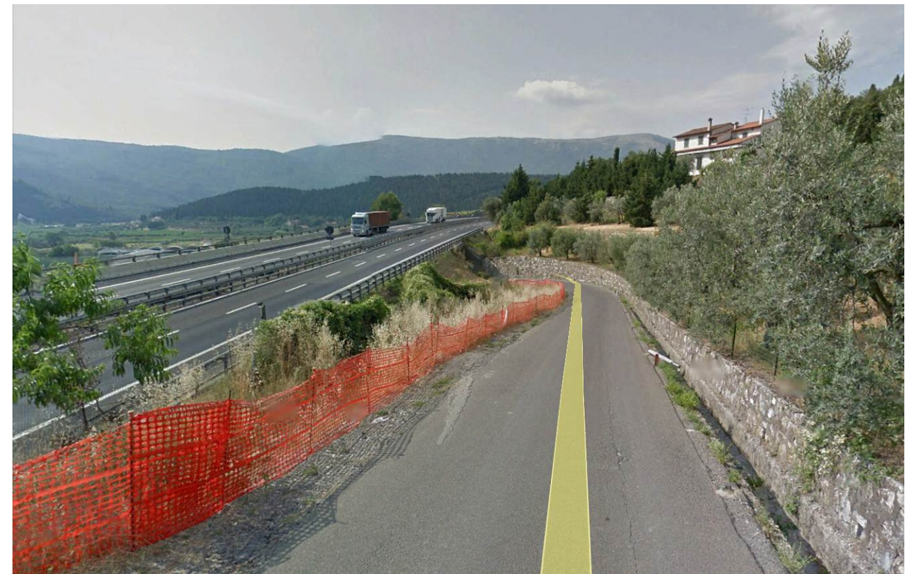
Figura 3.1.3.2 – vista sull'autostrada A1 sul tratto discendente di via del Colle
