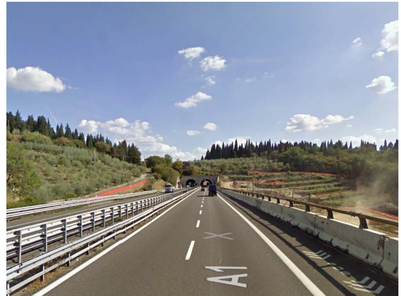
Figura 3.1.3.5 – vista dall'autostrada A1 dalla carreggiata sud-
