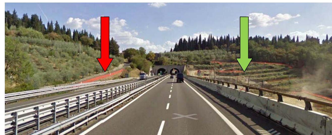
Figura 1.1 – Tratto autostradale di sottoattraversamento della nuova infrastruttura. Il versante della carreggiata nord (freccia rossa), ove sono previste le varianti al progetto definitivo già approvato, e il versante della carreggiata sud (freccia verde), ove saranno confermate le opere di sistemazione definitiva ricadenti nel progetto del Parco di Madonna del Facchino già autorizzato ed escluso dalla presente trattazione
