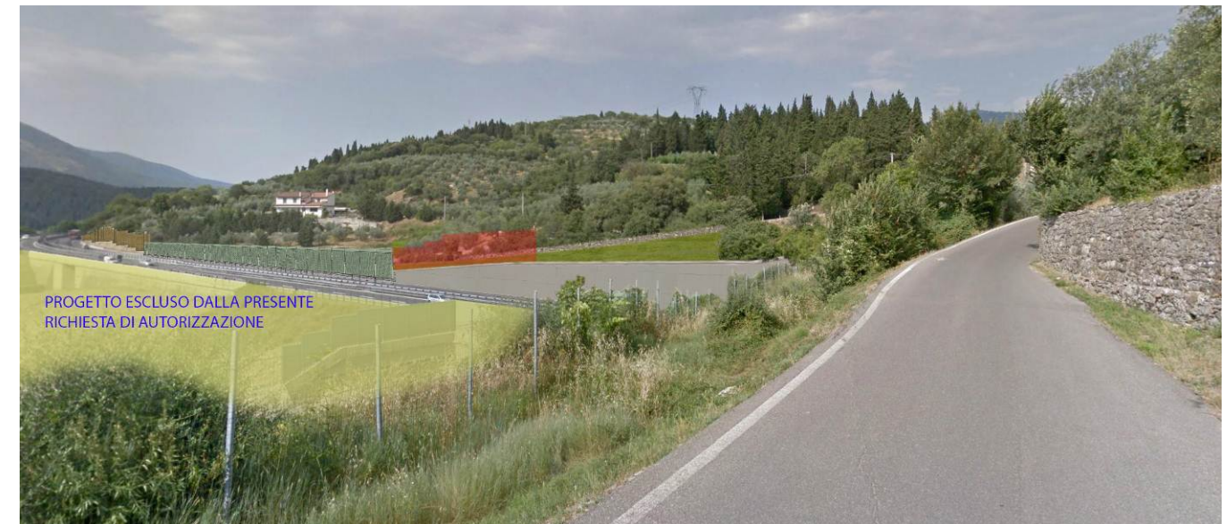
5.2.2 Variante al progetto autorizzato in CDS, lato carreggiata nord, vista verso l'autostrada: fotosimulazione dell'intervento. In trasparenza rossa il tratto di barriera acustica previsto per il progetto autorizzato e non più necessario. In giallo il lato della carreggiata sud (Parco Madonna del Facchino) non sottoposto alla presente procedura approvativa
