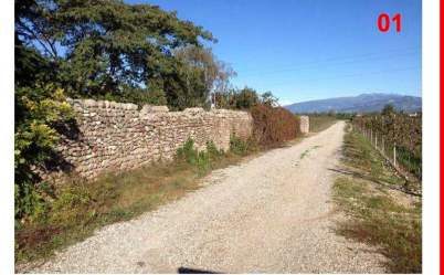
FOTO 01 - MURO IN CIOTTOLO
