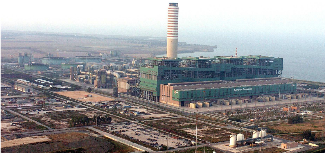
Figura 2.1.1 - Centrale Termoelettrica di Cerano (BR).
