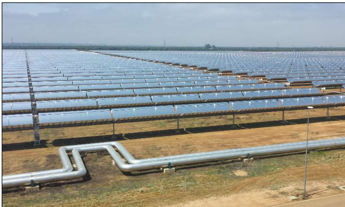
Figura 2: Impianto CSP esistente - Compensatori ad Omega
