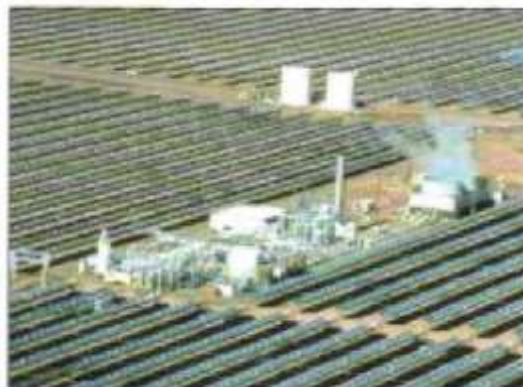
Figura 12 - Vista area di uno degli impianti di Kramer Junction
