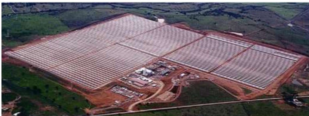
Esemio impianto CSP – Campo Solare
