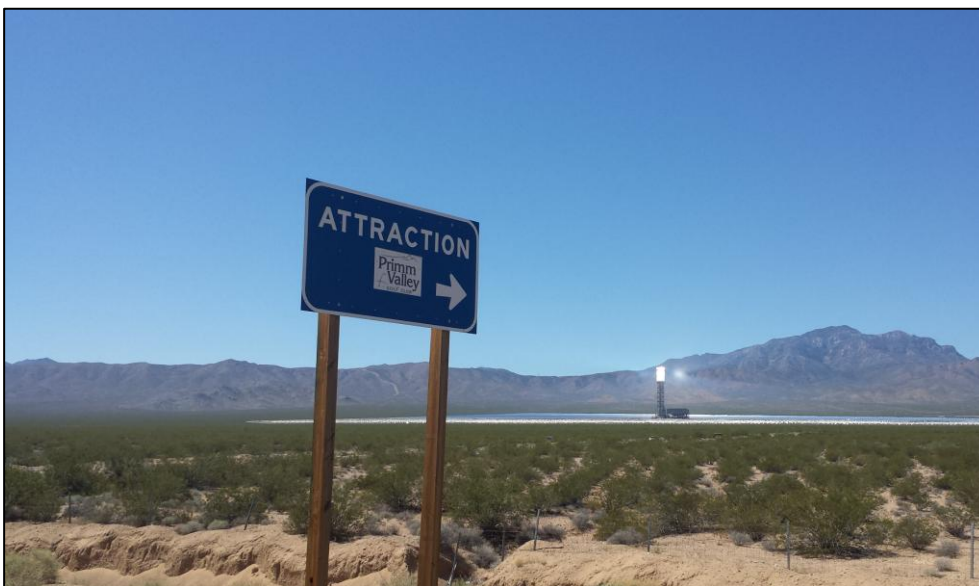
Figura 25: Impianto CSP a torre in California (USA)
