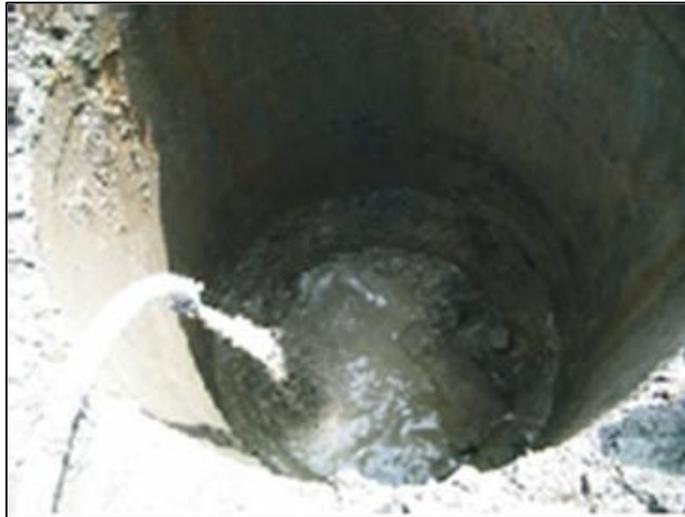
**Figura 10:** *Inserimento nel foro di materiale di riempimento*
