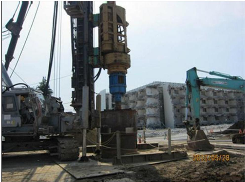
*Figura 7: Trivella di perforazione e rivestimento intorno alla cassaforma esistente*
