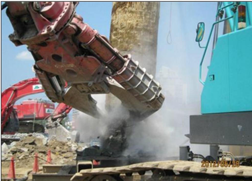
**Figura 9: Riduzione della cassaforma in pezzi più piccoli per facilitare il successivo trattamento e trasporto**
