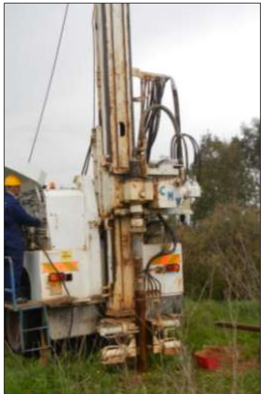
FOTO 6 – Operazione di rivestimento del foro.
