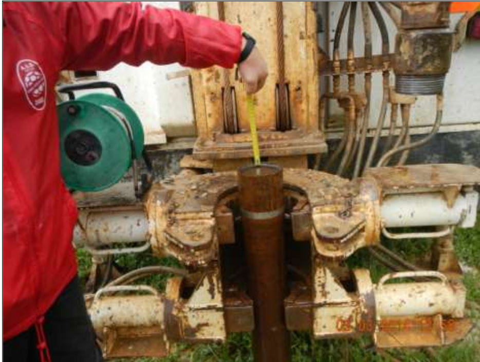
FOTO 30 – Esecuzione di prova di permeabilità a carico variabile nel BH4.
