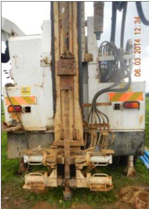
FOTO 11 - Esecuzione del test SPT.
