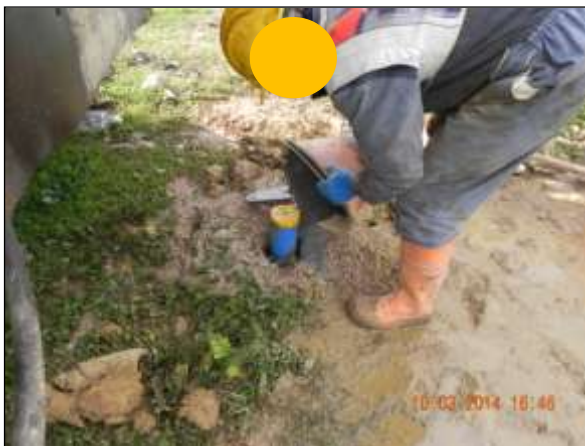
FOTO 16÷19 – Fasi di realizzazione del piezometro a tubo aperto.
