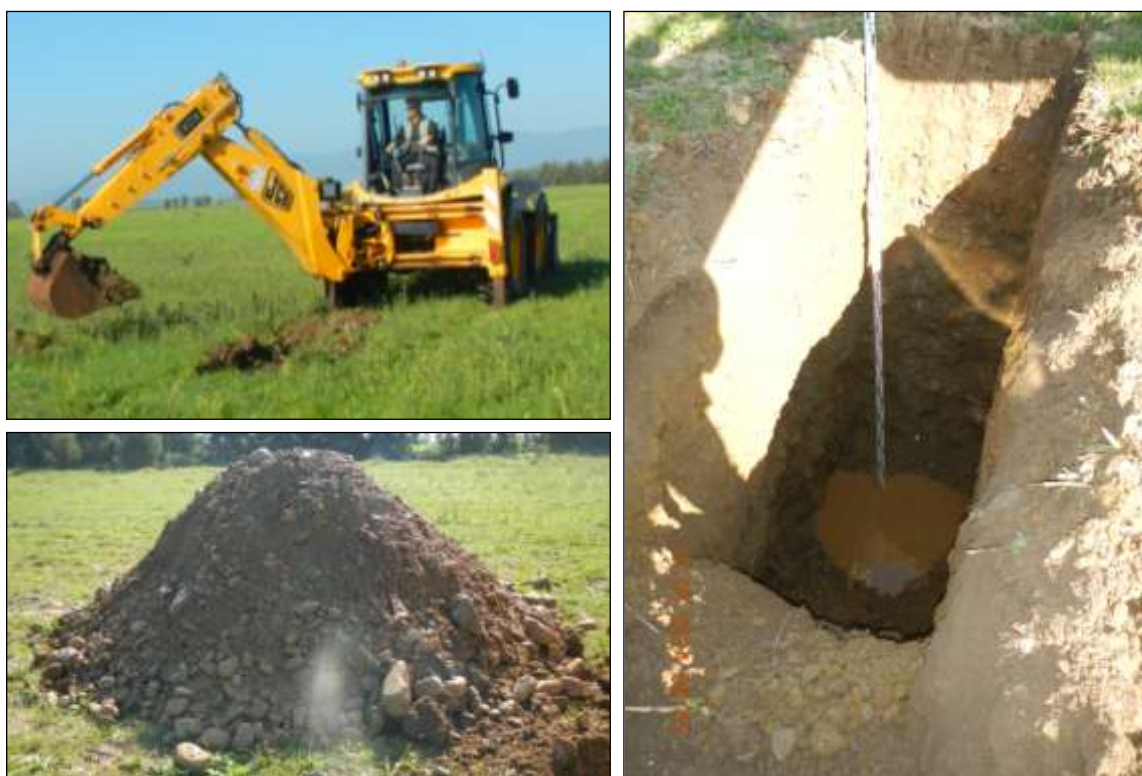
FOTO 8/10 - Esecuzione di pozzetto geognostico.
