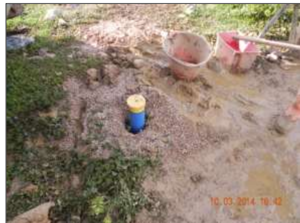
FOTO 16÷19 – Fasi di realizzazione del piezometro a tubo aperto.
