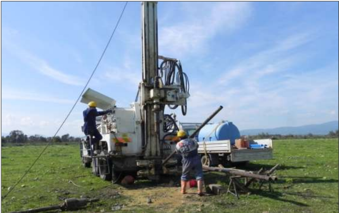
FOTO 4 - Sonda idraulica impiegata (BH6).
