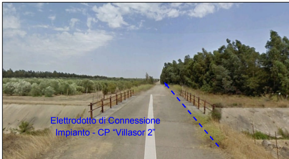
Figura 3: Elettrodotto di Connessione - Attraversamento Canale di Bonifica
