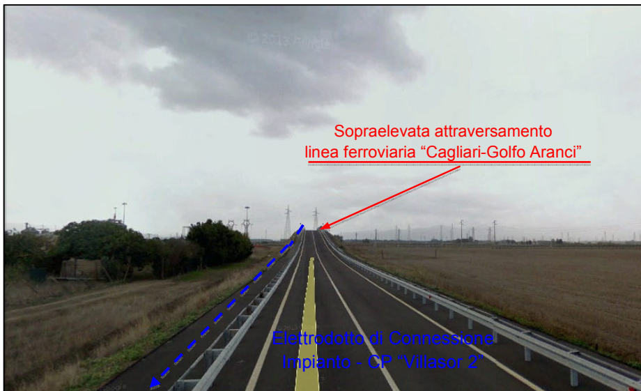
Figura 12: Elettrodotta di Connessione - Sopraelevata per attraversamento Ferrovia
