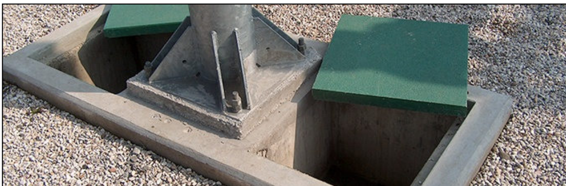
Figura 15: Esempio di copertura pozzetti con chiusini in PRFV
