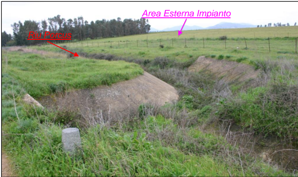
Figura 10: Presa fotografica PV 6b (Situazione Marzo 2013)
