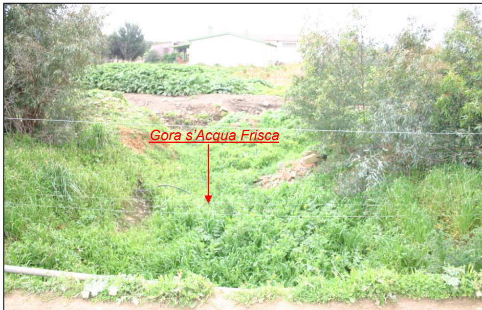
Figura 12: Presa fotografica PV 7b (Situazione Marzo 2013)
