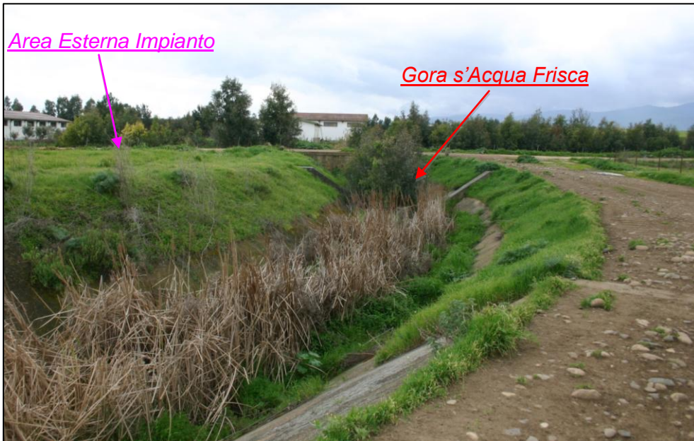
Figura 11: Presa fotografica PV 7a (Situazione Marzo 2013)
