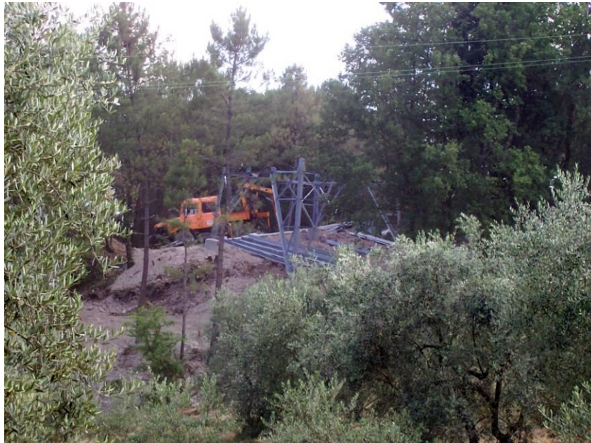
Foto 2 - esempio di area di micro cantiere
