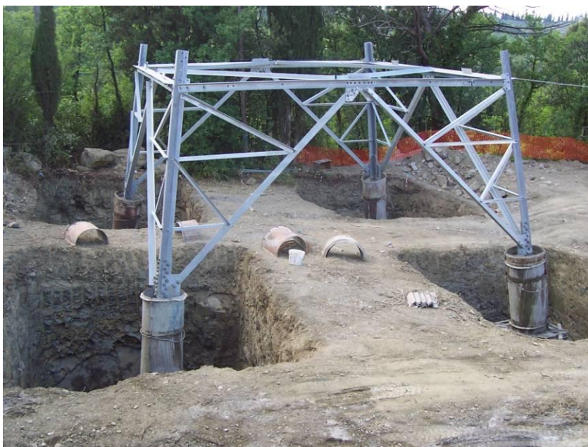
Foto 3 - Esempio di fondazione di un sostegno
