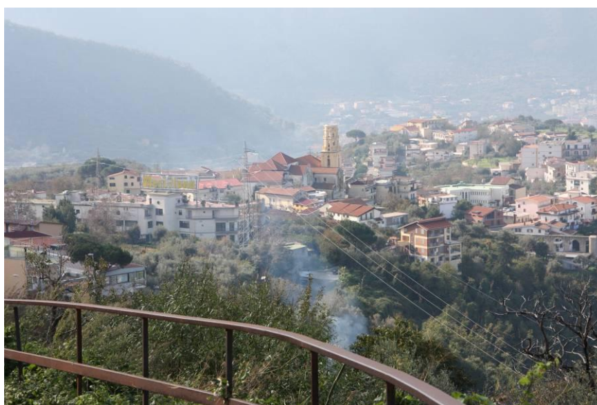
Foto 5 - elettrodotta da demolire nella frazione Piazza Roma (Lettere)
