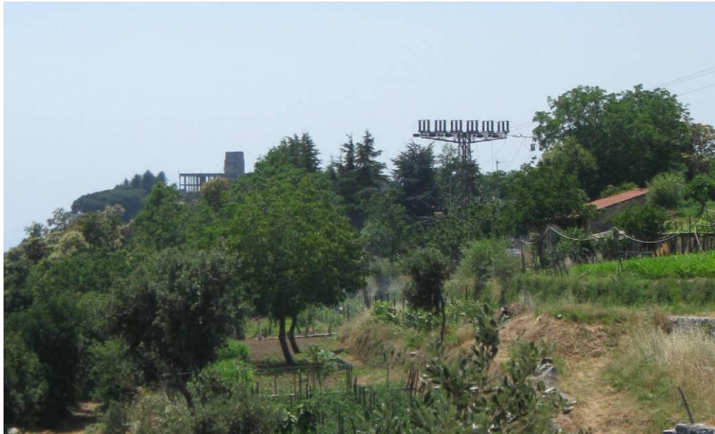
Foto 7 - una portale che verrà demolito in prossimità del Castello Lauritano
