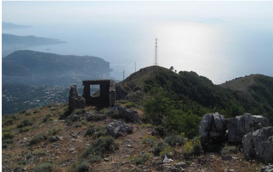
Foto 6 - un sostegno che verrà demolito sul Monte Faito
