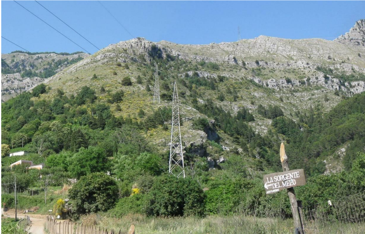
Foto 16 - la visibilità dei sostegni nella fascia 0 - 600 mt
