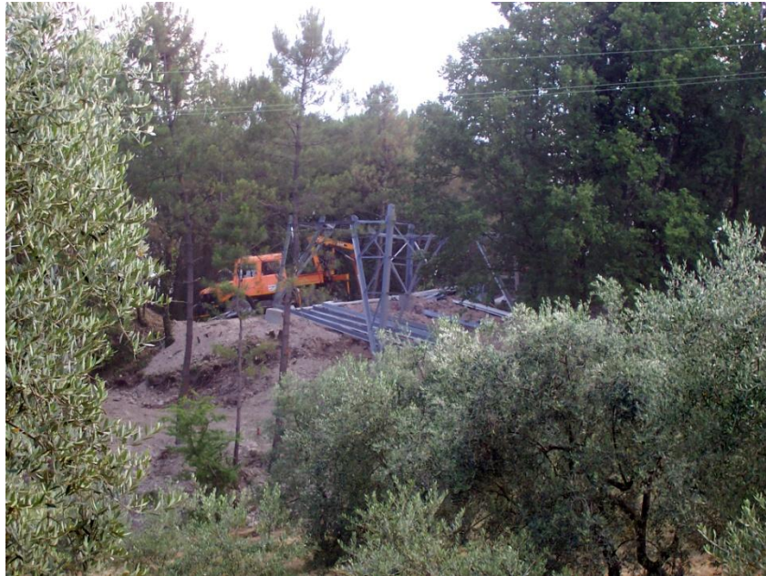
Foto 2 - esempio di area di micro cantiere
