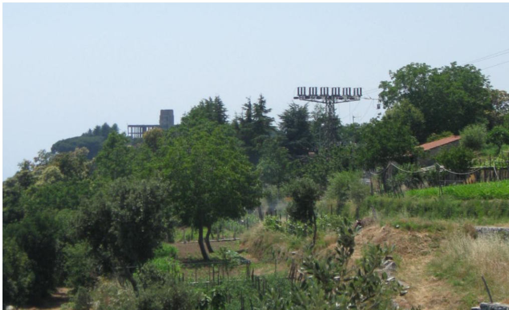
Foto 8 - Un portale che verrà demolito in prossimità del Castello Lauritano
