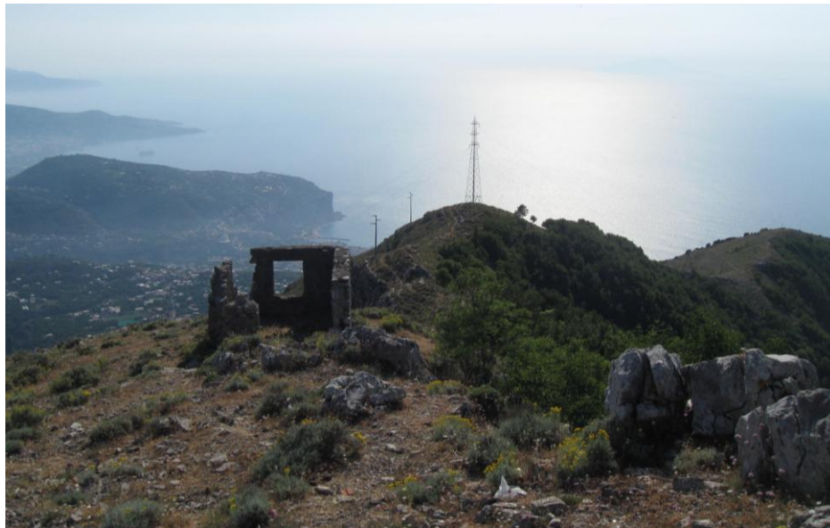
Foto 7 - Un sostegno che verrà demolito sul Monte Faito
