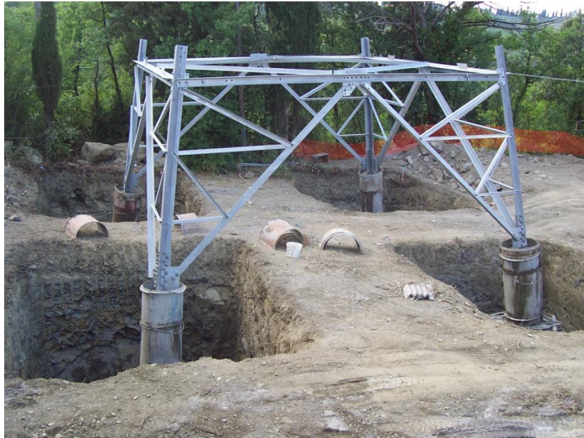
Foto 3 - Esempio di fondazione di un sostegno
