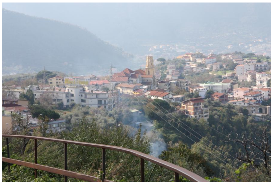
Foto 6 - Elettrodotto da demolire nella frazione Piazza Roma (Lettere)
