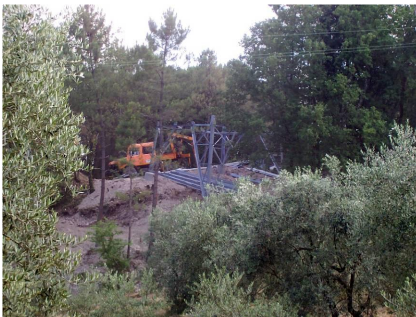
Foto 2 - Esempio di area di micro cantiere
