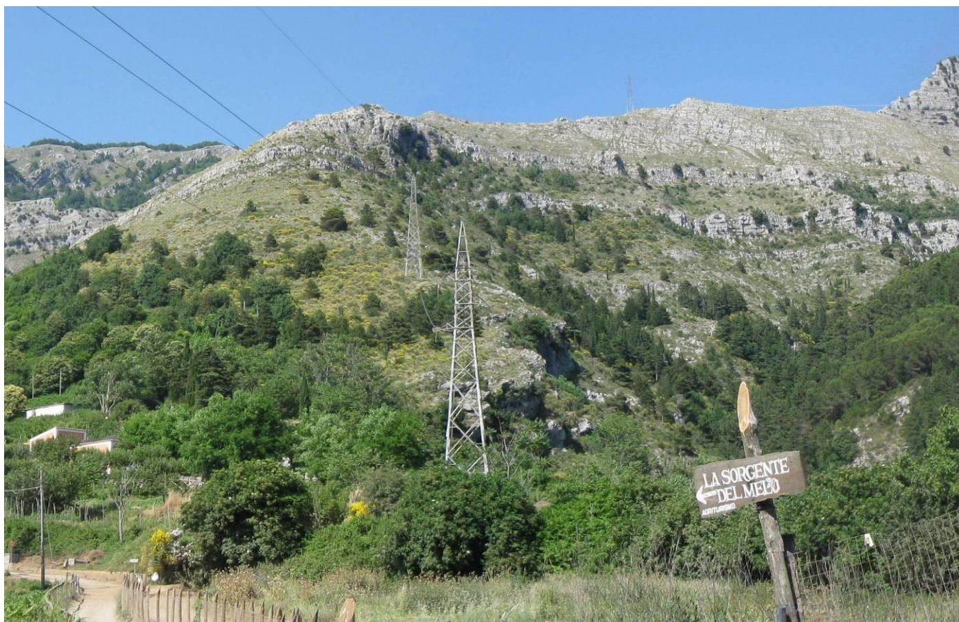
Foto 7 - la visibilità dei sostegni nella fascia 0 - 600 mt
