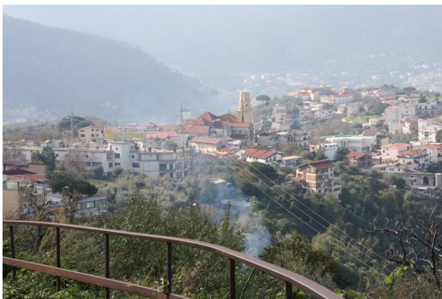
Foto 3 - Elettrodotto da demolire nella frazione Piazza Roma (Lettere)
